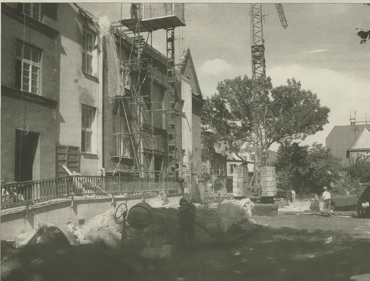
Podwórze jabłonkowskiej polskiej podstawówki przy ul. Szkolnej przekształcają się w plac budowy.
