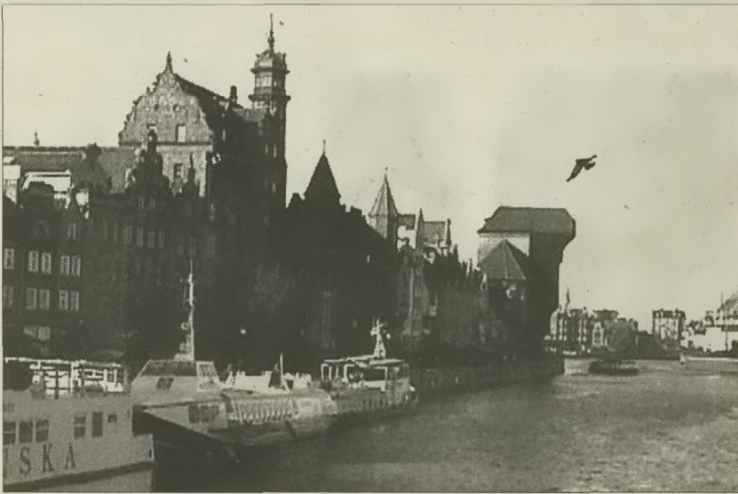
Żuraw góruje ponad kamieniczkami Długiego Pobrzeża nad rzeką Motławą. Dziś zamiast ruchliwego portu pełno tu jest restauracji, kafejek i sklepów z bursztynem.
