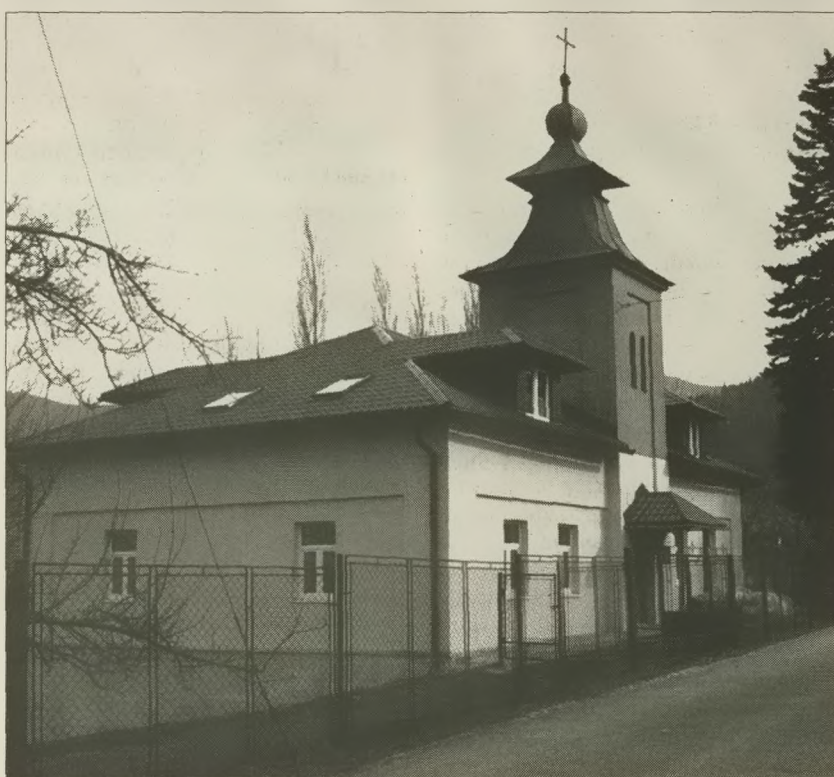
Budynek byłej polskiej szkoły w Gutach.
