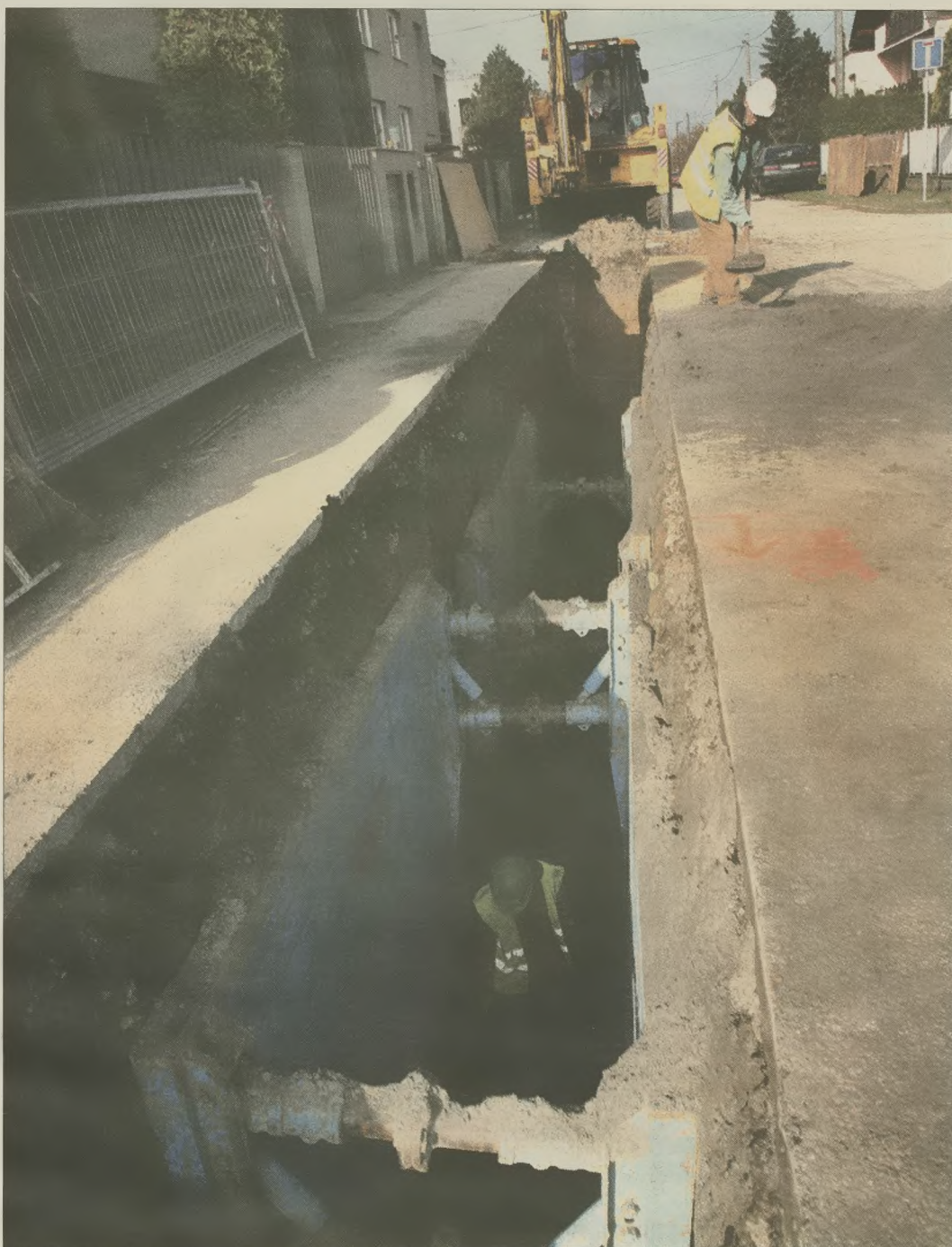
W Czeskim Cieszyńsku budowa kanalizacji już się rozpoczęła. W Jablonkowie sytuacja jest gorsza. Spółka, która wygrała przetarg, kwestionuje ważność umowy i nie chce rozpocząć prac ziemnych.
