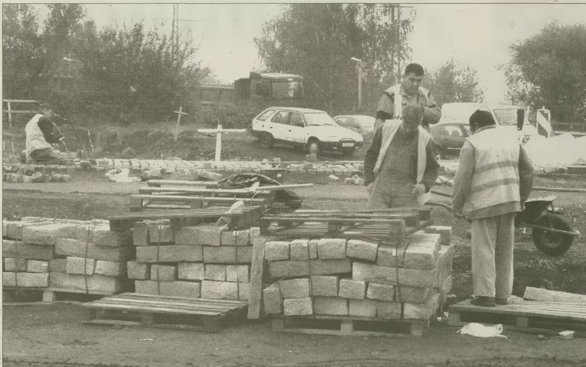
Robotnicy na budowie nowego ronda w Skrzeczoni.
