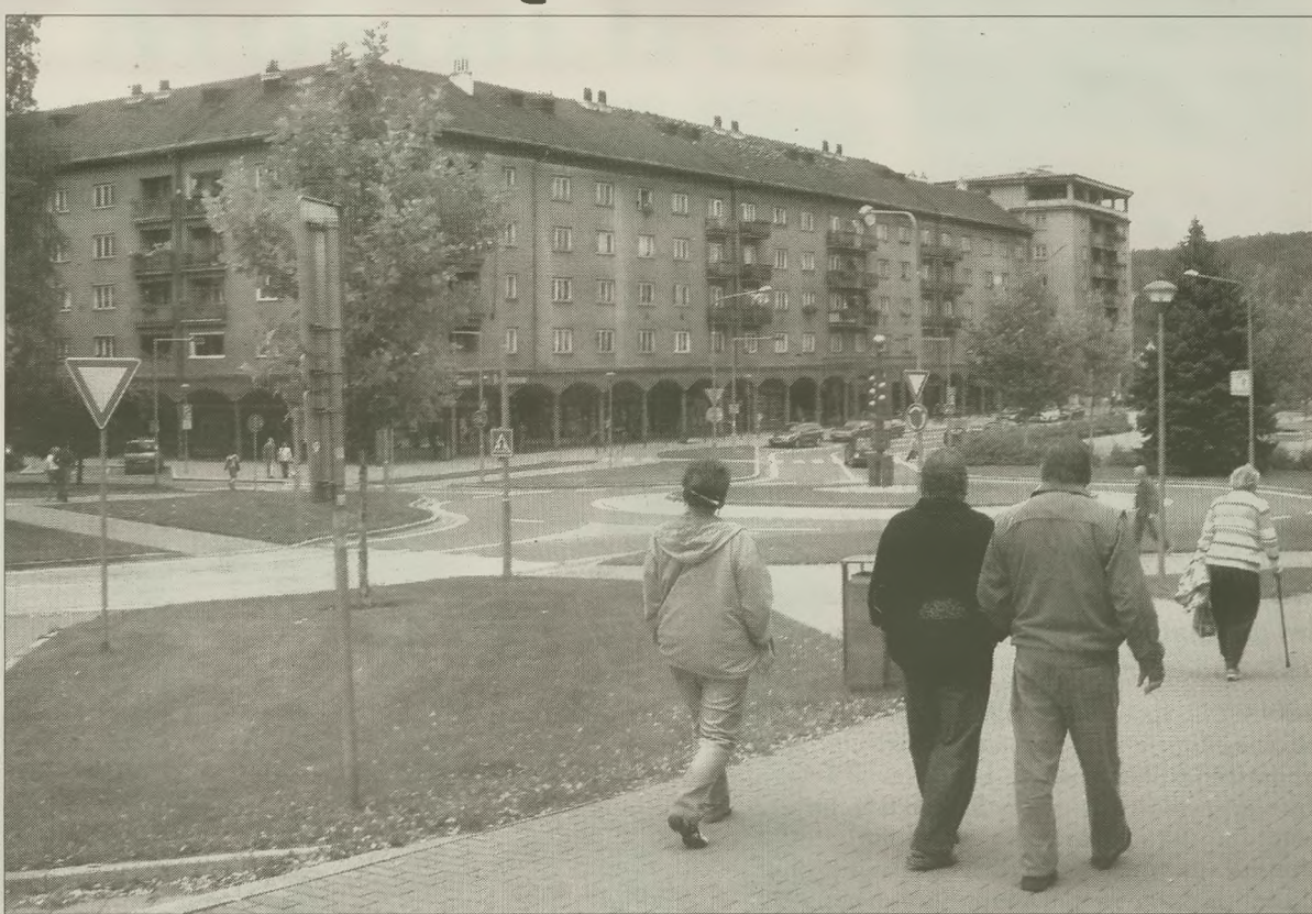
Zaniedbane domy mieszkalne spółki Byty Třinec szpecą odnowiony rynek T. G. Masaryka.
