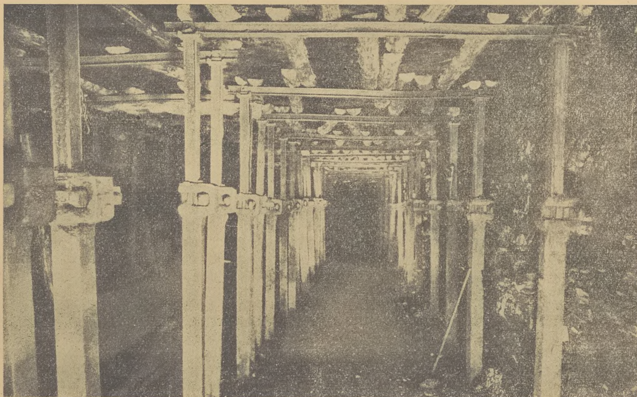
Rys. 1. Ogólny widok obudowy stalowej w ścianie
