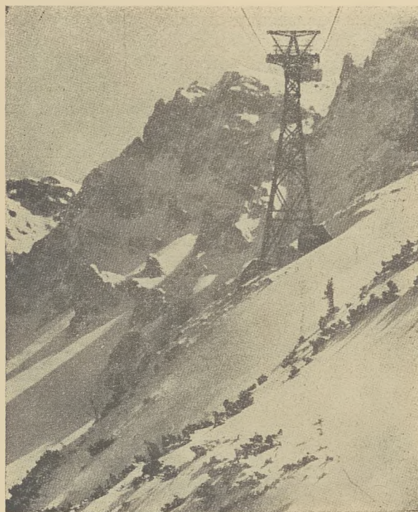
Rys. 3. Jeszcze jeden maszt kolejki linowej i jesteśmy na Kasprowym
