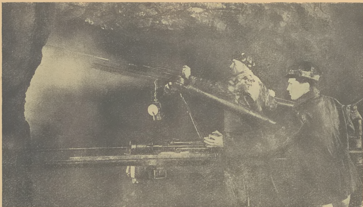
Rys. 6. Wiercenie otworów strzałowych ciężką wiertarką na podpórcę
