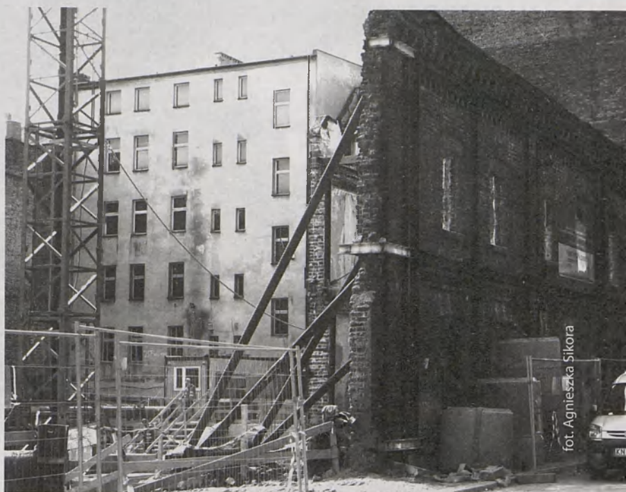
Budowa Wydziału Radia i Telewizji Uniwersytetu Śląskiego
