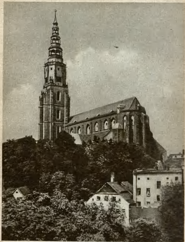
Die katholische Kirche in Schweidnitz The catholic church in Schweidnitz Katolska kyrkan i Schweidnitz
