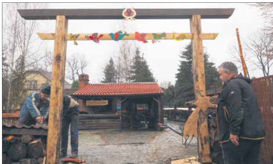
Brama torii podczas budowy
