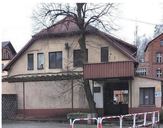
152. Brama i markownia przed rozbiórką.
