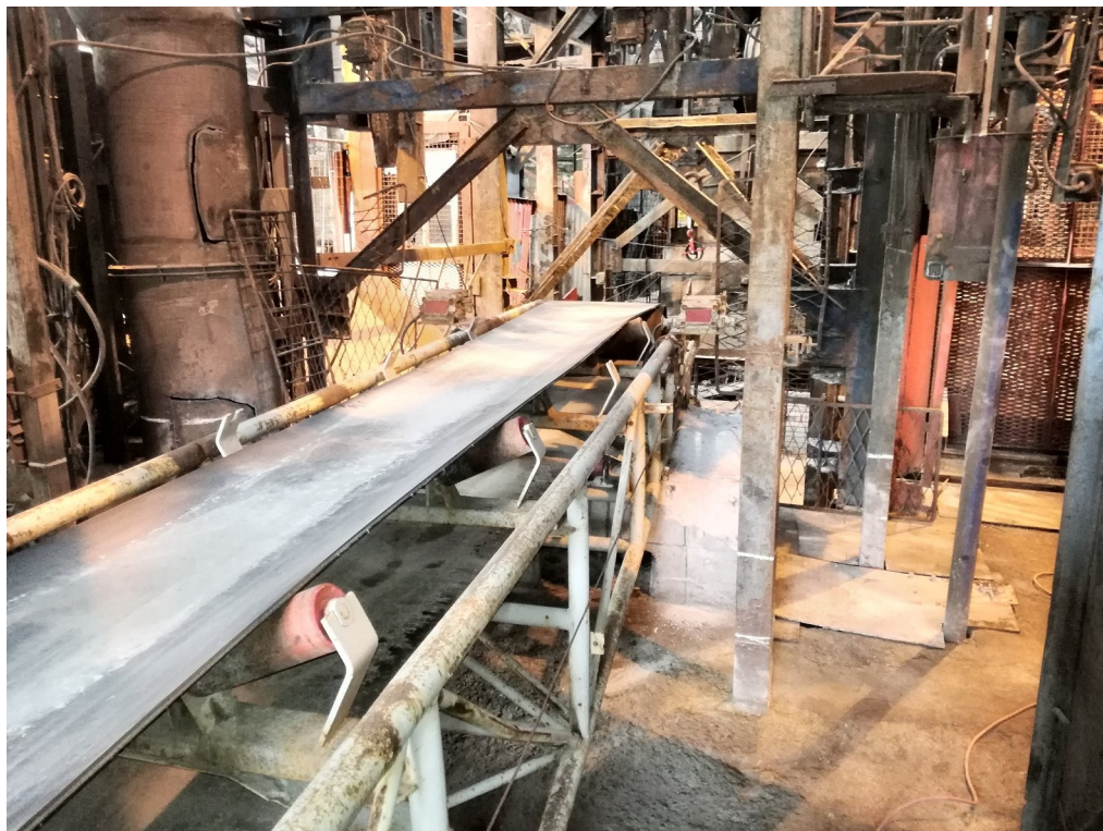
147. Montaż taśmociągu do zasypywania szybu „Chrobry I”.
