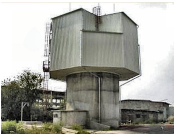
128. Dyfuzor tłumiący hałas wentylatorów szybu „Jedłownik III”.
