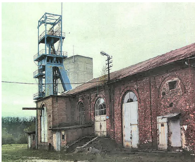
82. Nowa wieża i budynek maszynowy z przybudówką dla zamieszczenia maszyny wyciągowej.
