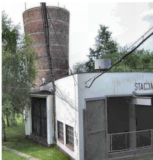
86. Budynek i dyfuzor „Szybu Powietrznego II”.
