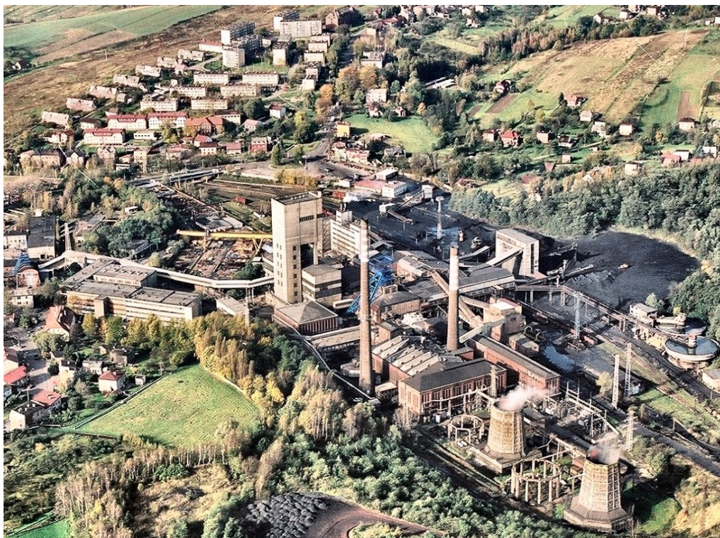
123. Widok kopalni z lotu ptaka.
