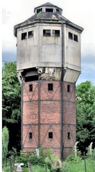
31. Wieża ciśnieniowa. Widok po jej unieruchomieniu w latach 60. XX wieku.
