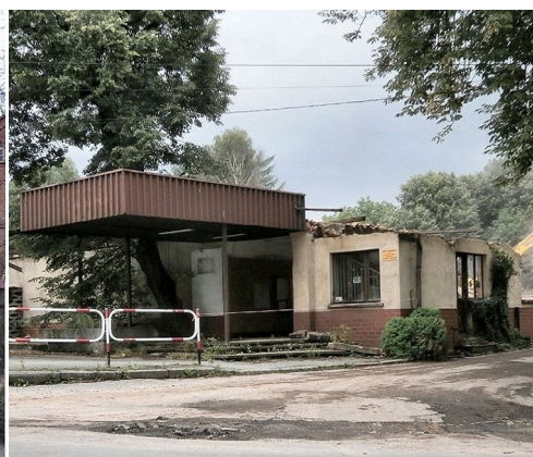
153. Rozbiórka budynku markowni.
