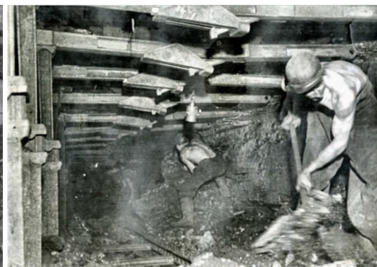
76. Załadunek urobku w ścianie z obudową stalowo-członową.
