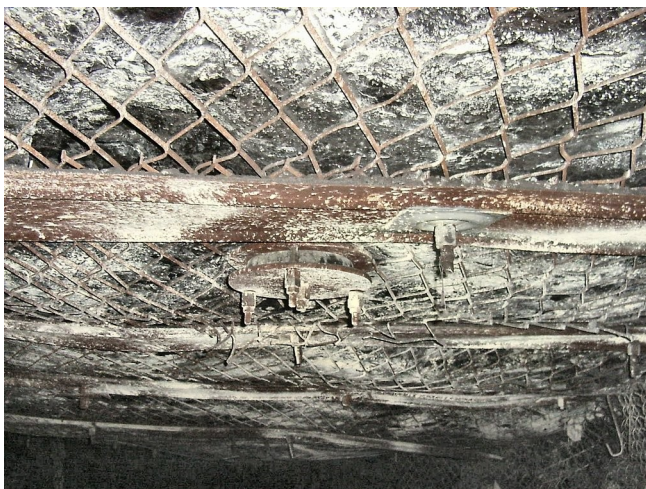
108. Strop wyrobiska zabezpieczonego obudową kotwioną.
