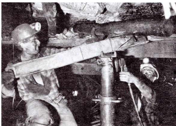
98. Zabezpieczanie stropu przy pomocy stojaka SHC.
