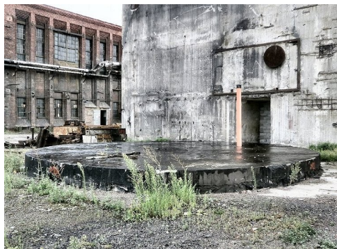
143. Płyta zamykająca zasypywany szyb „Chrobry II”.
