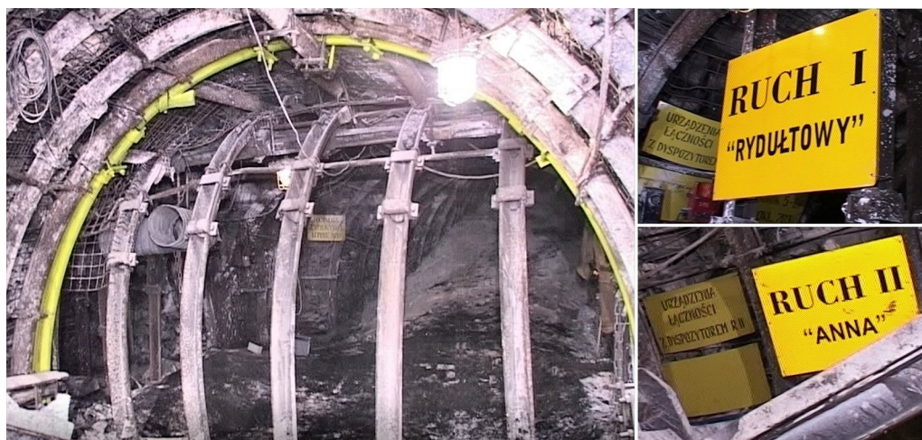
131. Połączenie podziemne ruchów „Rydułtowy” i „Anna”.
