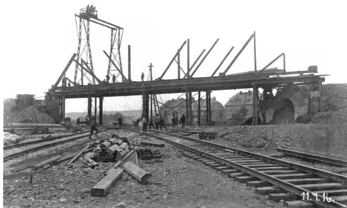
32. Budowa wiaduktu drogowego przy kopalni.
