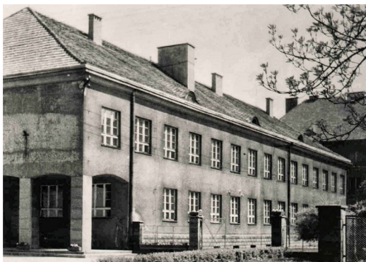
73. Nowy budynek szkolny z 1951 roku. Za nim widać internat wybudowany w 1957 roku.
