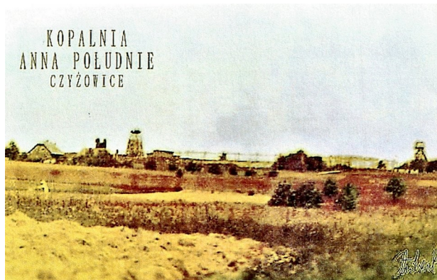
100. Kopalnia „Czyżowice” w budowie, z prawej szyb III, z lewej szyb II w głębinie.
