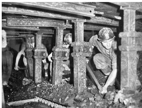
75. Załadunek urobku w ścianie ze stropnicami z szyn.
