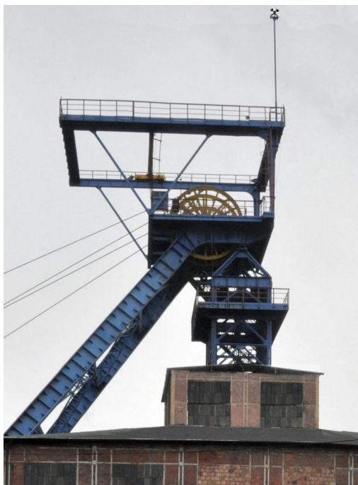
118. Nowa wieża szybu „Chrobry I”.
