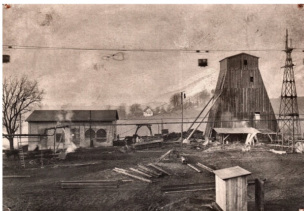
30. Głębenie szybu Rudolf. Tymczasowa wieża szybowa.
