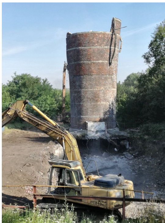
148. Rozbiórka dyfuzora szybu „Ryszard II”.
