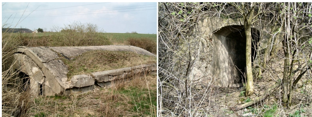
29. Budynek magazynu materiałów wybuchowych oraz przejście w wale ochronnym.
