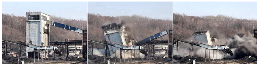
144. Wysadzenie zbiornika na węgiel przy zakładzie przeróbczym.
