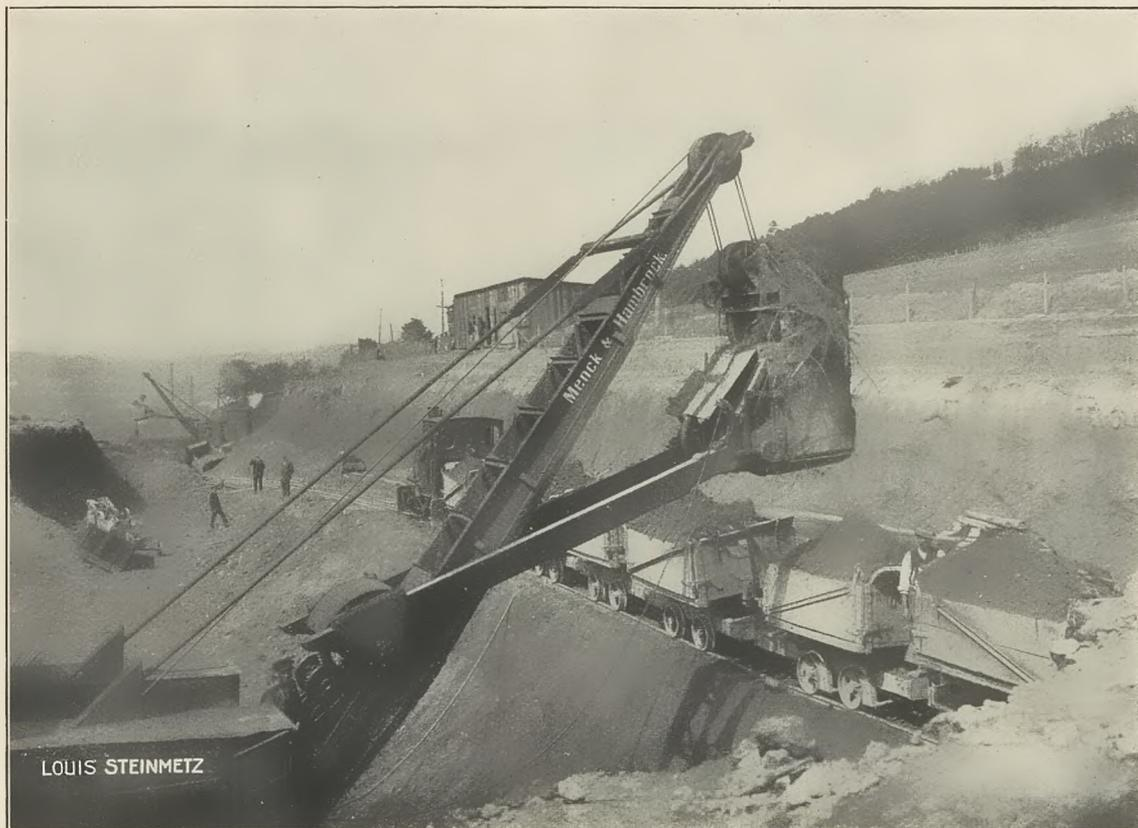
Bahnhofsumbau Dieringhausen 1913-1917, 650 000 cbm Bodenbewegung ( $\frac{1}{3}$  Erde,  $\frac{2}{3}$  Felsen), 30 000 cbm Mauerwerk, wie Über- und Unterführungen, Stützmauern usw.
