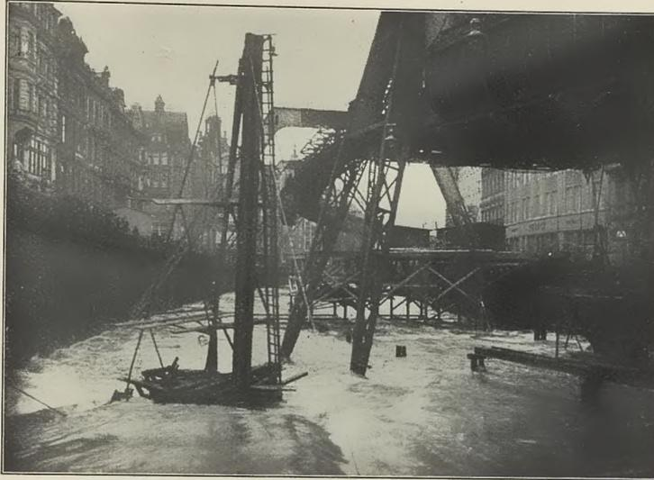
Da der alte Schwebebahnhof dem Verkehr nicht mehr genügte, plante man schon seit längerer Zeit seine Erweiterung. Die Siemens-Bauunion hatte Entwürfe für den Umbau des Bahnhofes ausgearbeitet und wurde im Oktober 1924 mit der Ausführung der Bauarbeiten für den neuen Bahnhof betraut. Zur Gründung des neuen Bauwerks waren umfangreiche Rammarbeiten erforderlich. Die Wupper wird durch schwere Eisenkonstruktionen zur Aufnahme der Bahnhofshalle überbrückt werden.
