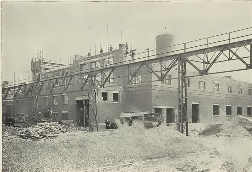
Kraftwerk der Eisenbahnwerkstätte Schwerte. Rutschflächen der Kohlenbunker und Aschenspülrinnen in Stahlbeton aus met. Härtematerial von der Firma Fritz Ebener, Essen.
