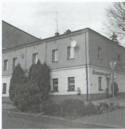
Druga (i ostatnia) siedziba Sądu Powiatowego przy ul. Bytomskiej 30 (róg ulicy Bytomskiej i Szpitalnej), w której Sąd zajmował pierwsze piętro budynku, widok z 2021 r.
