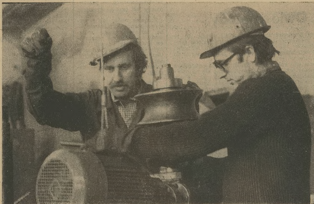
Antoni JAWOR i Jerzy WRÓŃSKI przy montowaniu przekładni napędowej samotoku.
