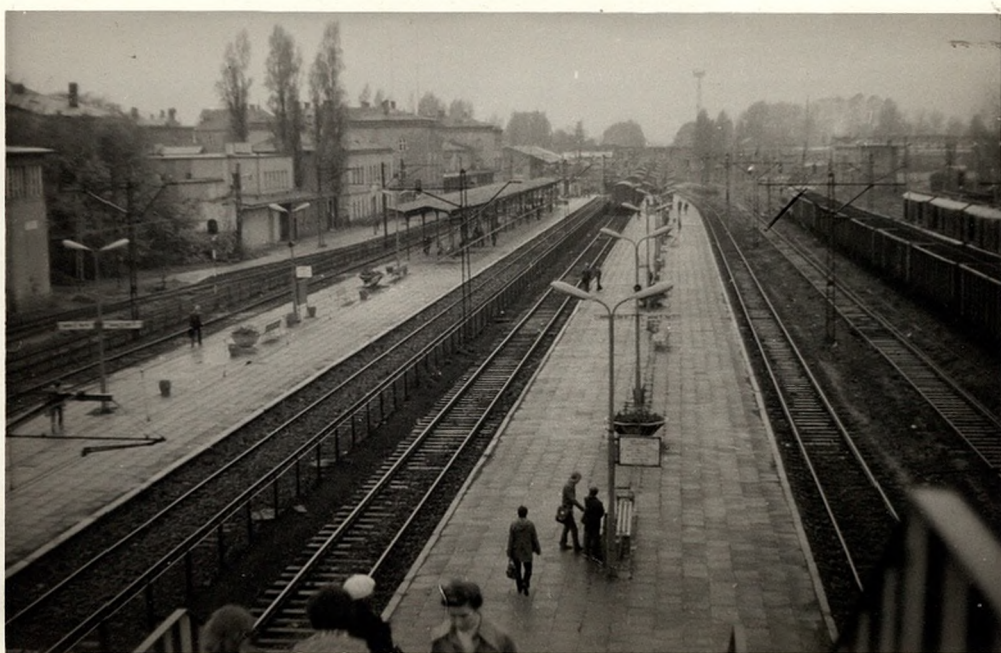
Widok na perony i nowo trakcje elektryczne
