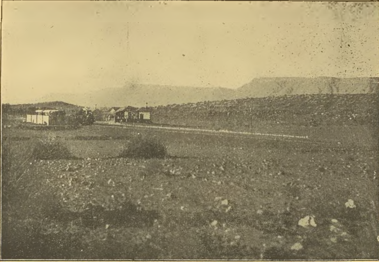
Station Holoog der Strecke Seeheim-Kalkfontein-Süd.
