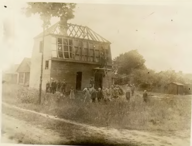
1 Budowa szkoły polskiej w Wyrzynie 14 IX 31.
