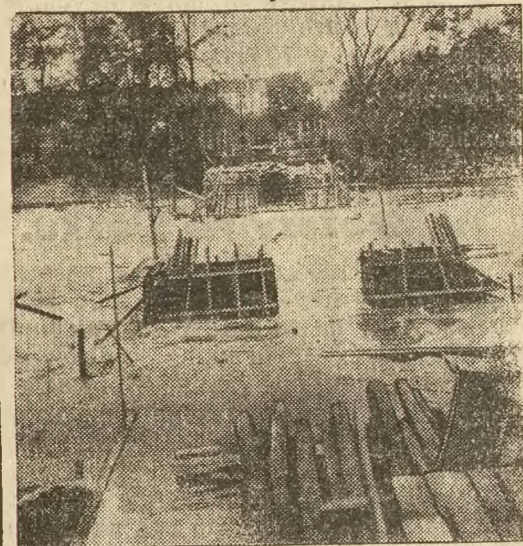
Zniszczony przez wodę most w jednej z miejscowości Śląska Opolskiego.
