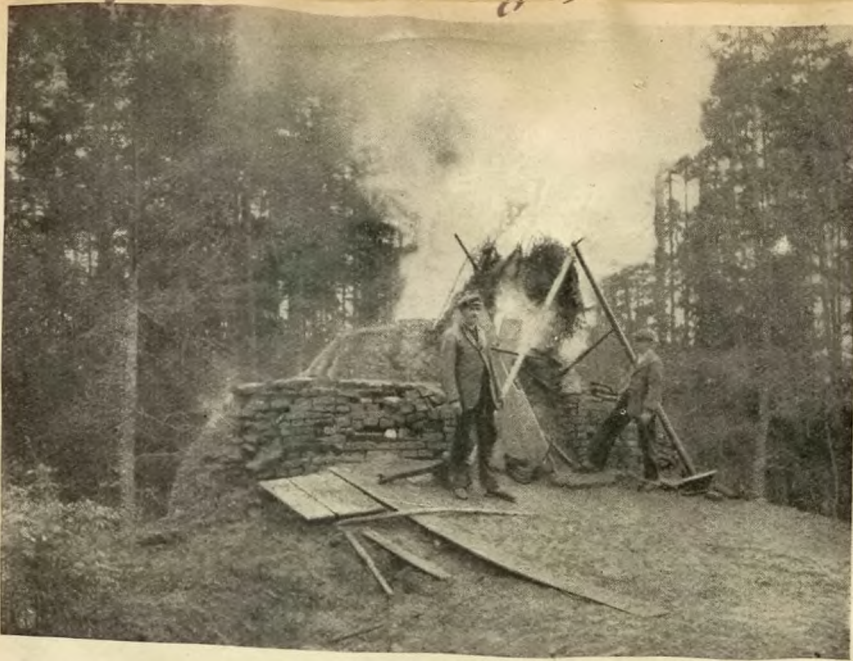
Abb. 2: Pechofen in Betrieb. In der Kuppel des Ofens wurde 3 Tage nachdem das Feuer angelegt war ein Loch von etwa 10 cm Durchmesser ausgehauen, aus welchem dann Dampf auströmte.
