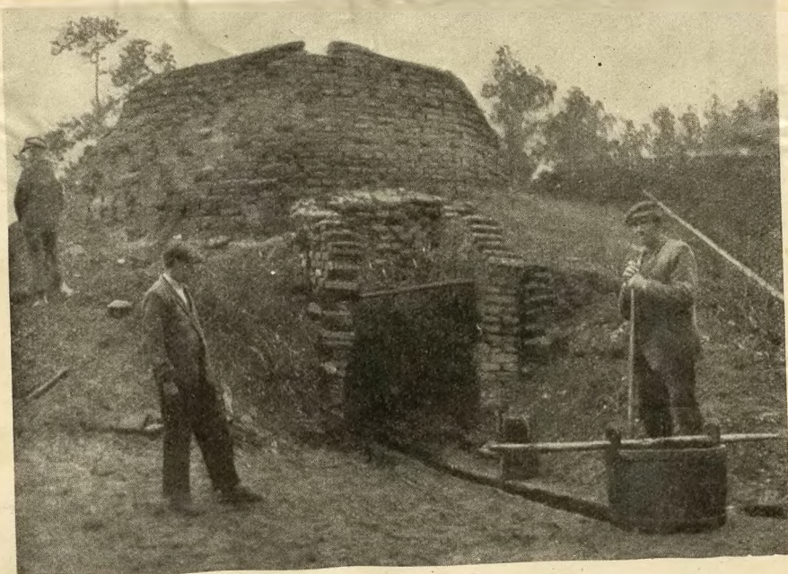
Abb. 1: Pechofen bei Lugnian in der Nähe von Jellowa in Oberschlesien. Der Ofen ist seit 1927 nicht mehr in Betrieb. Man erkennt die Abflußrinne für das Harz.
