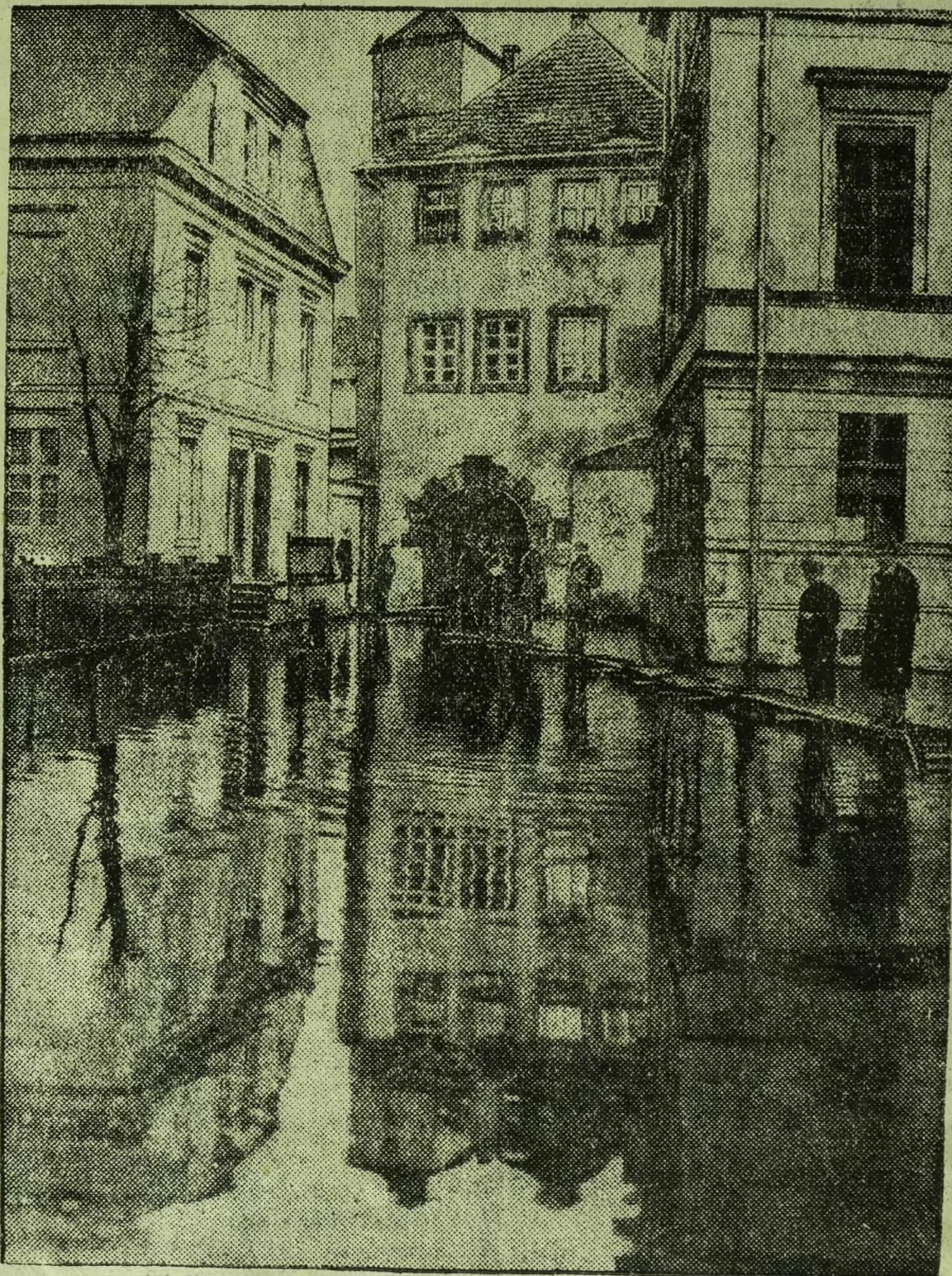
Skutki powodzi na przedmieściu miasta Crossen nad Odrą.
