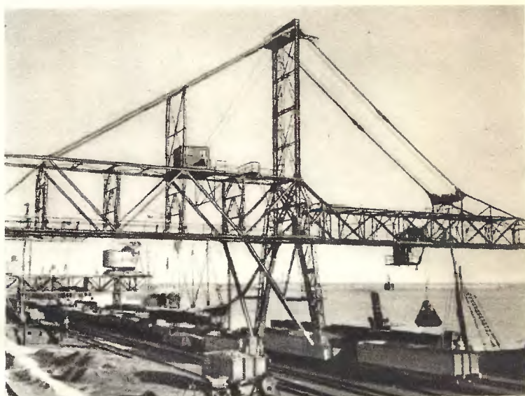
Most przeładunkowy o rozpiętości 80 m, całkowitej długości 120 m, dostarczony w r. 1927 Urzędowi Morskiemu w Gdyni.
