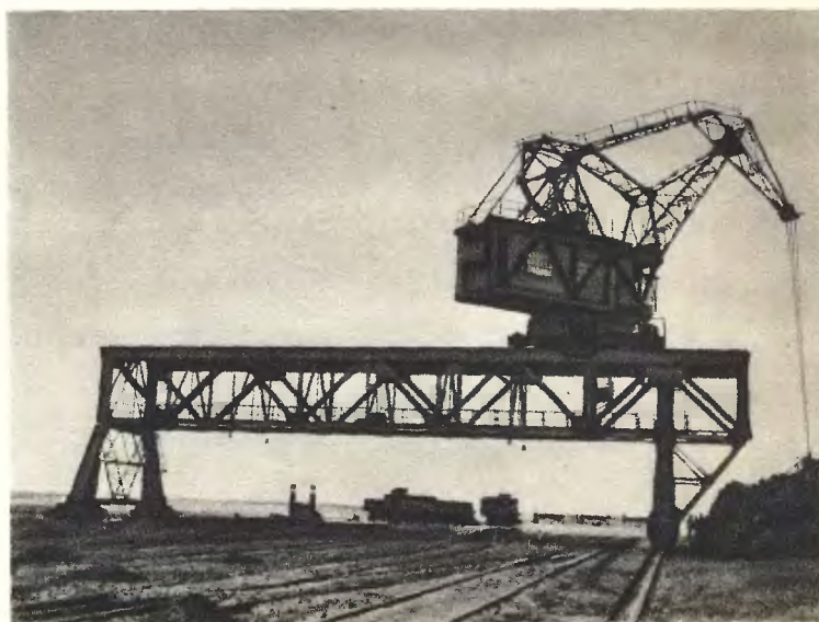
Dźwig mostowy dla przeładunku węgla, zbudowany w r. 1936 dla Progress. Rozpiętość mostu 28,9 m, nośność 7,5 ton, wydajność godzinowa do 150 ton.
