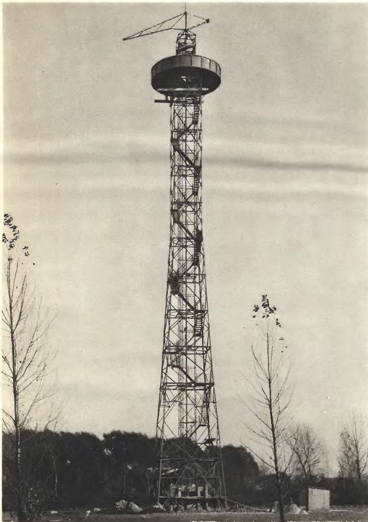
Wieża do skoków spadochronowych w Katowicach. Konstrukcja stalowa. Wysokość 50 m. Waga 40 ton. Szybkość spadania regulowana automatycznie (patent inż. Szwabowicza). Mechaniczny wyciąg osobowy. Zamówienie: LOPP. Wykonanie i montaż: »Warsztaty Przetwórcze« w Chorzowie.
