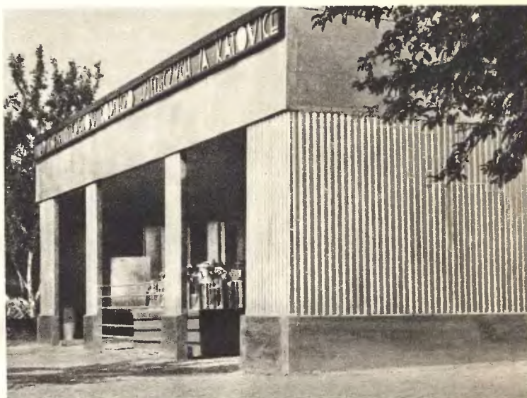
Kiosk wystawowy naszej konstrukcji kryty w całości blachą falistą i płaską, zastosowany przez nas na Wystawie »Praca i Kultura Wsi« w Liskowie 1937 r.
