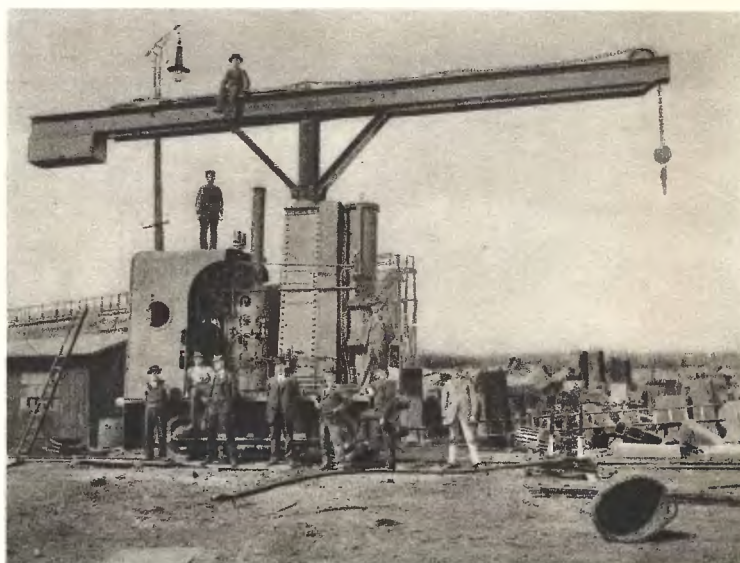
Parowy żuraw obrotowy jezdny, nośność 3.000 kg, wysięg 4 m, dostarczony w r. 1898 dla fy Borsig.
