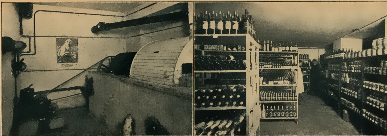
Kühlmaschinen-Anlage
