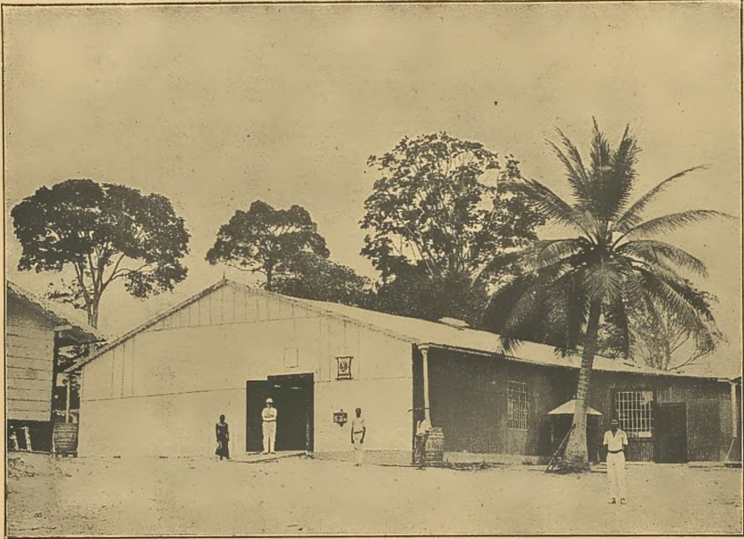
Laden- und Kontorgebäude mit Kaiserl. Deutscher Reichspost-Agentur in Longji (Kamerun), errichtet aus Patent-Eisenkonstruktion und eingedeckt mit EM „REX“ Flinddach.
