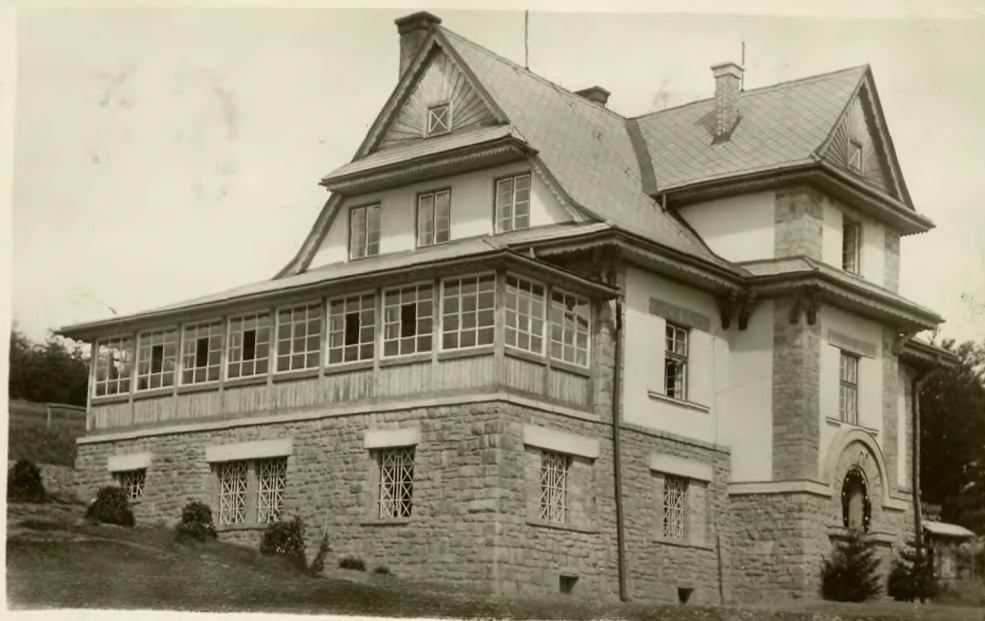
Schronisko na linii „Kozubowej“
