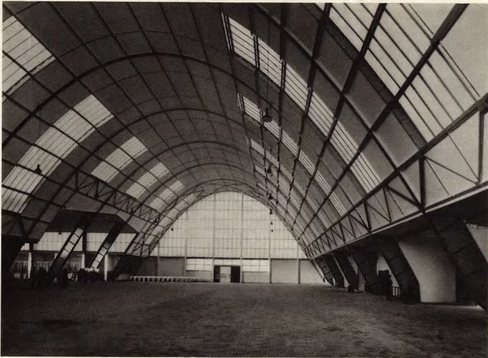
Konstrukcja stalowa Hali Targowej w Gdyni wykon. »Warsztaty Prze- twórcze« w Cho- rzowie. (Widok ogólny Hali Gdyń- skiej przy art. »Este- tyka budowli prze- mysłowych«).
