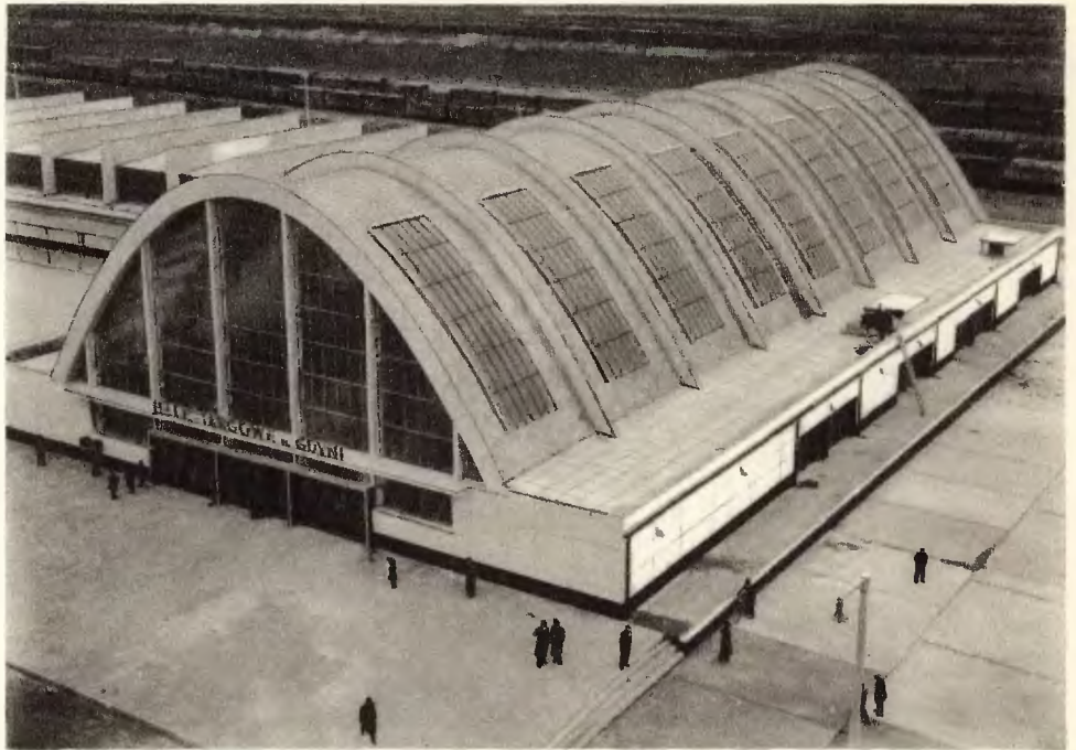
Hala Targowa w Gdyni — Zwraca uwagę piękna forma całości, oparta na estetycznej więźbie konstrukcji stalowej, wykonanej przez »Warsztaty Przetwórcze« w Chorzowie
