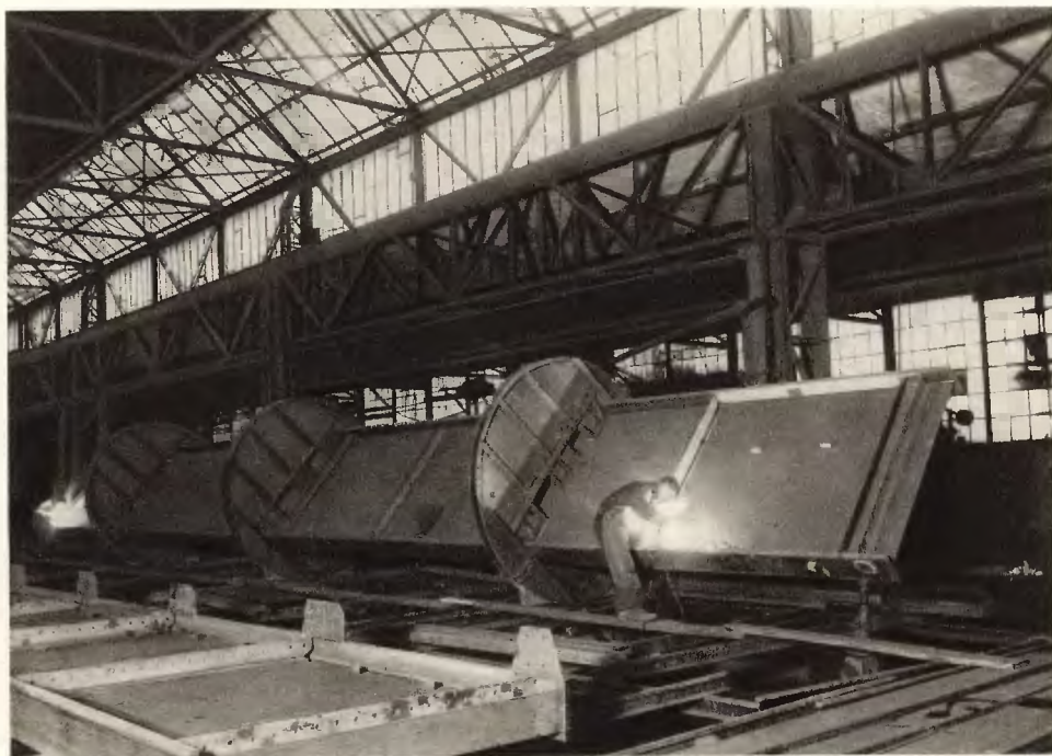
Mostowa belka blaszana na tarczach, służących do przetaczania.
