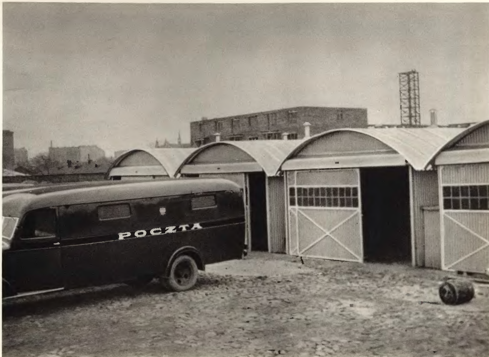
Seria garaży samochodowych z blachy falistej ocynkowanej wykonana dla Okręgowej Dyrekcji Poczty i Telegrafów w Warszawie, przez hutę »Laura« w Siemianowicach.
