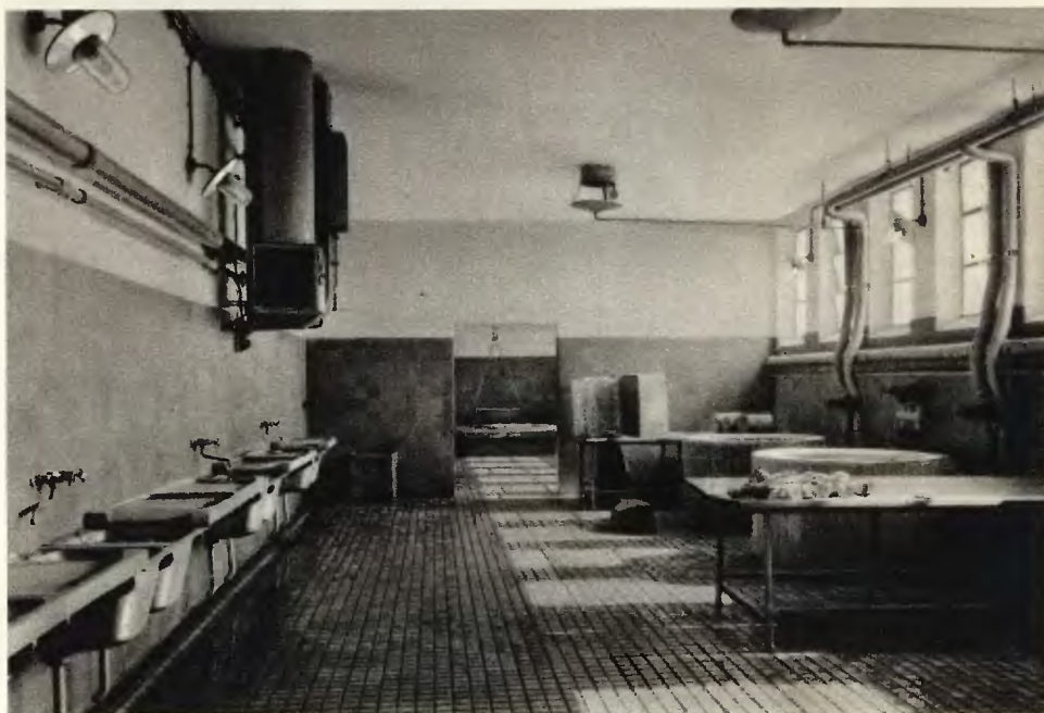
Pluczkarnia dla wnętrzości bydła grubego. Z lewej strony naczynia z stolikami, z prawej oparzelniki oraz stoły robocze. Przez otwór w ścianie widoczna jest ubikacja dla wypróżniania żołądków, z niecką na wnętrzości.
