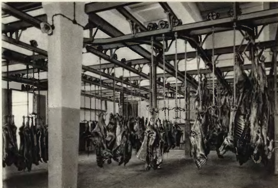
Hala łączna — część z kolejką dwuszynową, przylegająca do hali uboju bydła.
