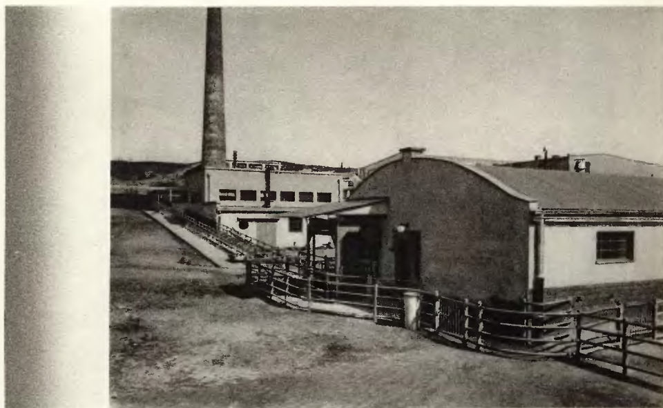
Rzeźnia i Targ. Zwierz. w Gdyni — na pierwszym planie zagrody spędowe i chlewy dla świń z korytarzem, łączącym zagrody i chlewy z halą uboju. Na bocznej ścianie chlewów pod daszkiem z blachy falistej, widoczna jest waga o nośn. 1.000 kg do ważenia żywych świń.
