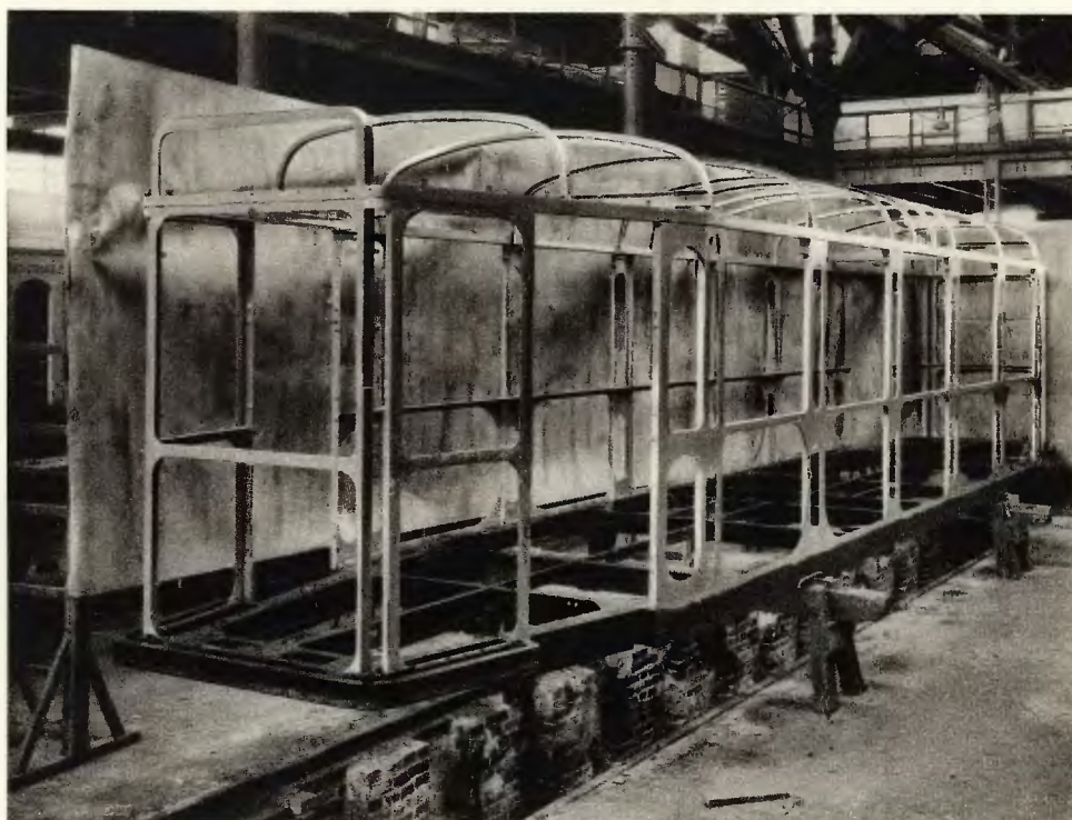
Konstrukcja wozu tramwajowego dla m. st. Warszawy.
