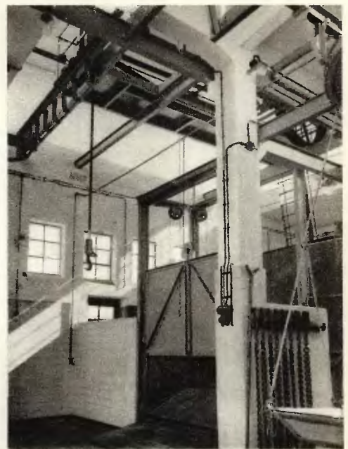
Zatoka ubojowa dla bydlą grubego z podniesionymi drzwiczkami i przechylnym pomostem. Na prawej ścianie zatoki — jednokołowe wózki z łańcuchami — z lewej strony zatoki zwisa na łańcuchu hak dla podnoszenia wózków z bydłem na tor skrwawienia.
