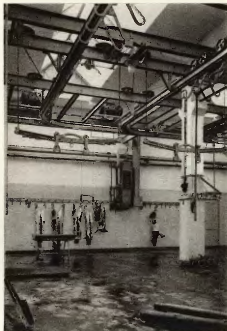
Fragment hali uboju z automatycznymi rozpinaczami, dwuszynową kolejką wiszącą i konstr. żel. dla podparcia kolejki. U góry na konstrukcji elektr. windy bezpieczeństwa oraz poziome i pionowe rolki prowadnicze dla lin, na których zawieszono są rozpinacze.
