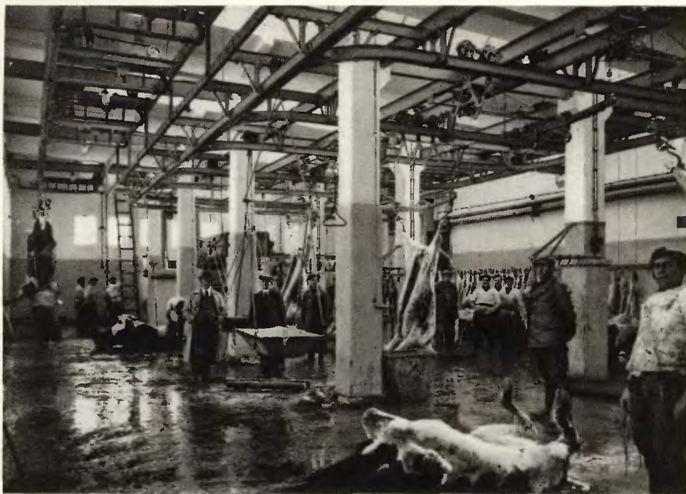
Ogólny widok hali uboju bydła grubego i drobnego. W lewej, górnej stronie widać urządzenia, które opuszczają na specjalnie wykształconym haku wózek wraz z bydlęciem z toru skrwawienia na podłogę. Na prawej stronie ramy hakowe dla bydła drobnego.
