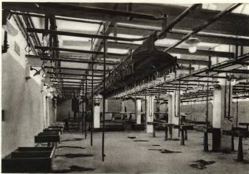
Kolejka rurowa w hali uboju świń tworząca 56 stanowisk do opracowania po 1 świni na każdym stanowisku równocześnie. Każde stanowisko posiada stolik dla kontroli wnętrzości, prysznic do zmywania tusz i haczyk dla zawieszenia wątroby.
