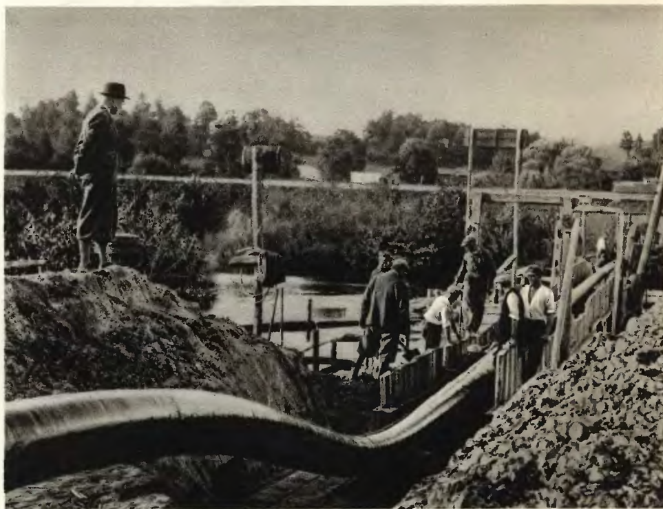
Fragment gazociągu »Polminu« 260 km (Jasło—C. O. P.) ułożonego w roku 1937 wyłącznie z rur stalowych bez szwu »W. I.«
