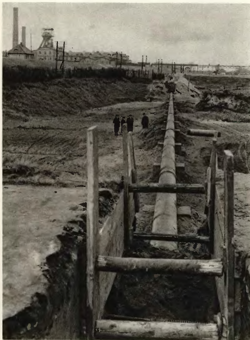
Budowa rurociągu Ø 500 mm Dąb—Świętochłowice. Rurociąg w nasypie przed kopalnią »Kleofas«, Katowice-Załęże.
