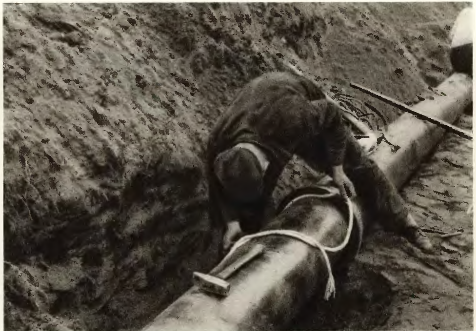
Uszczelnianie rur żeliwnych.
