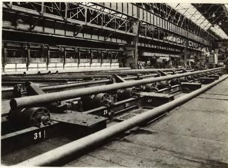
Rurownia w hucie »Batory« — na rolkach transportowych rura stalowa \varnothing — 101 mm długości 34.300 mm.
