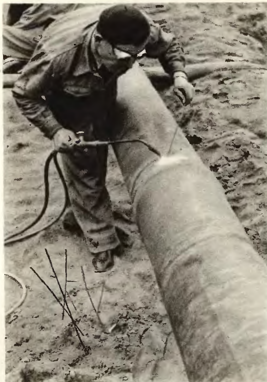
Spawanie rur stalowych.
