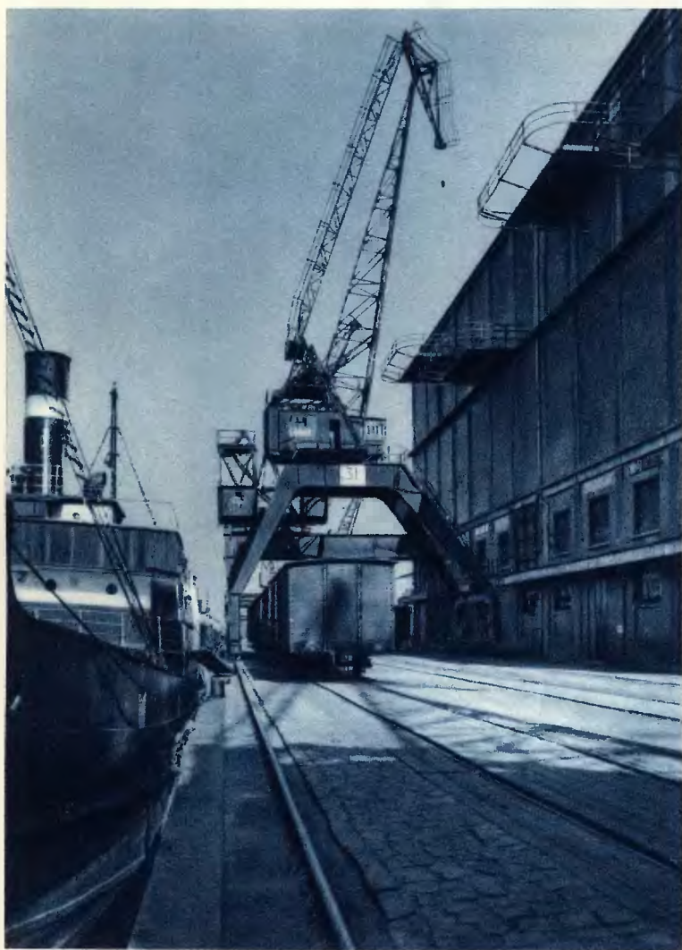
Ryc. 3. Portalowy żuraw drobnicowy, chłodniowy na Nabrzeżu Polskim w Gdyni.
