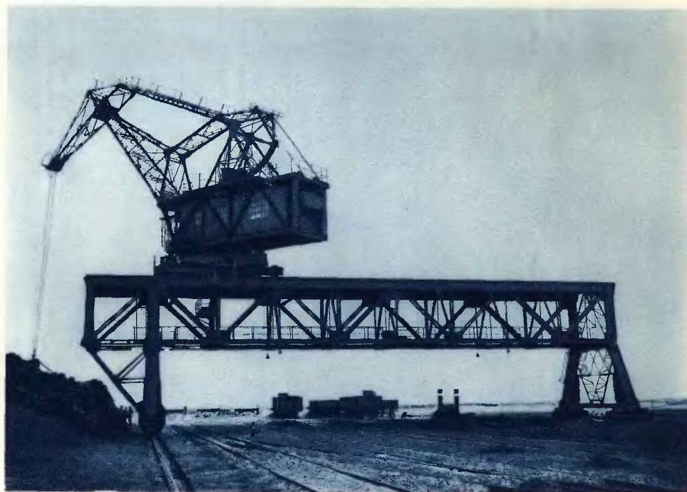
Ryc. 4. Mostowy żuraw chwytałowy (Elabor) na Nabrzeżu Śląskim w Gdyni.
