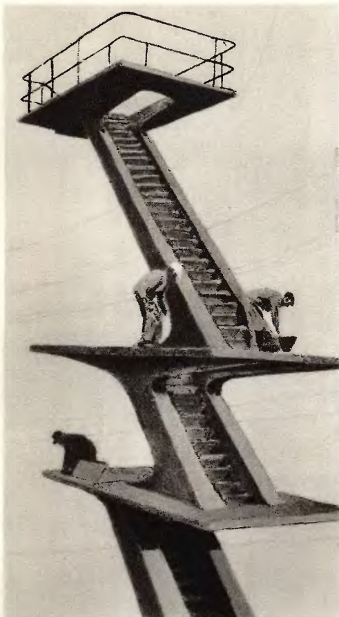
Żelbetowa wieża do skoków pływackich, w kąpielisku na Sołacz w Poznaniu, uzbrojona stalą »Griffel«.
