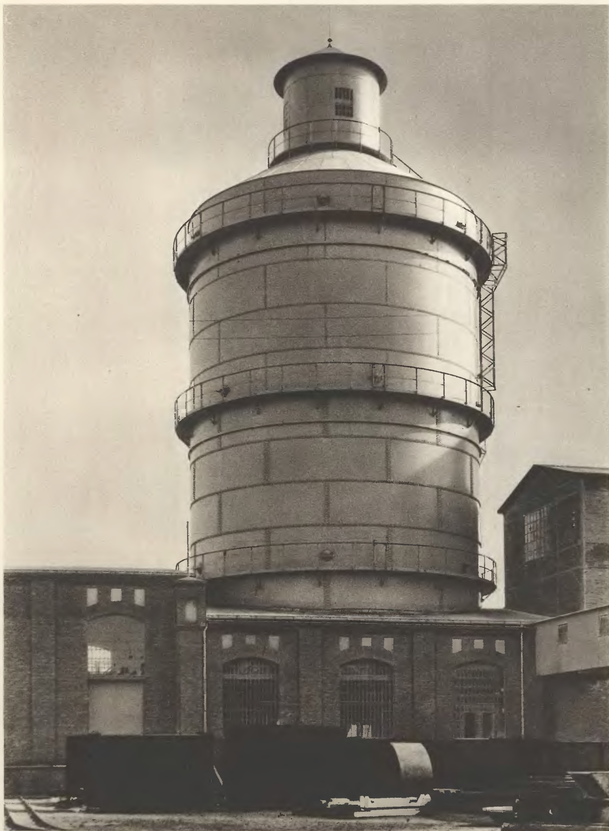
Silos o średnicy 15 m i wysokości 34 m dostarczony przez Zakłady Budowy Maszyn »Huta Zgoda« dla fabr. chem. »Polskich Zakładów Solvay« w Mątwach.
