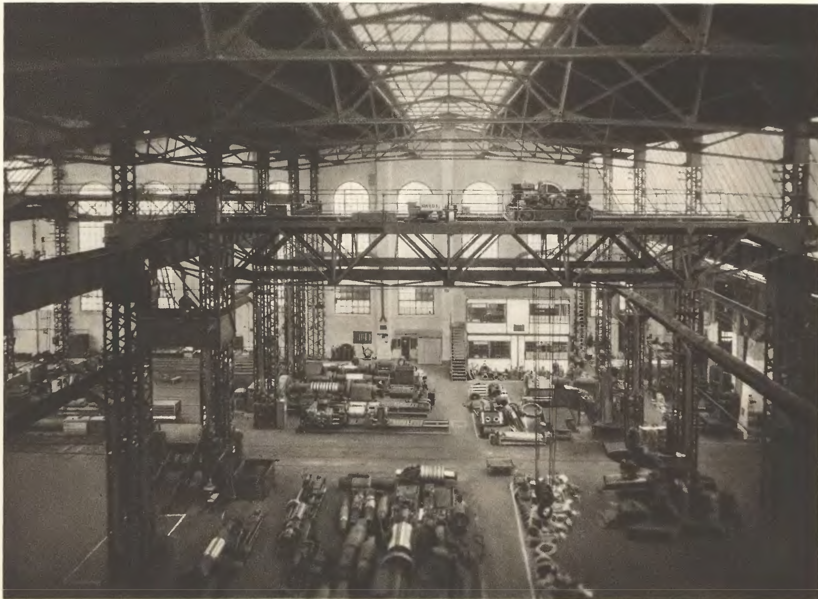
Suwnica elektrycz- na o nośności 30 ton wykonana przez Zakłady Budowy Maszyn »Huta Zgo- da« dla własnego warsztatu mecha- nicznego.
