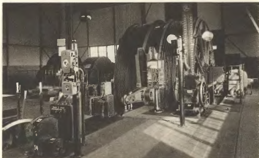
Ryc. 24. Elektryczna maszyna wydobywcza na kopalni »Prezydent Mościcki« wykonana przez Zakłady Budowy Maszyn »Huta Zgoda«.
