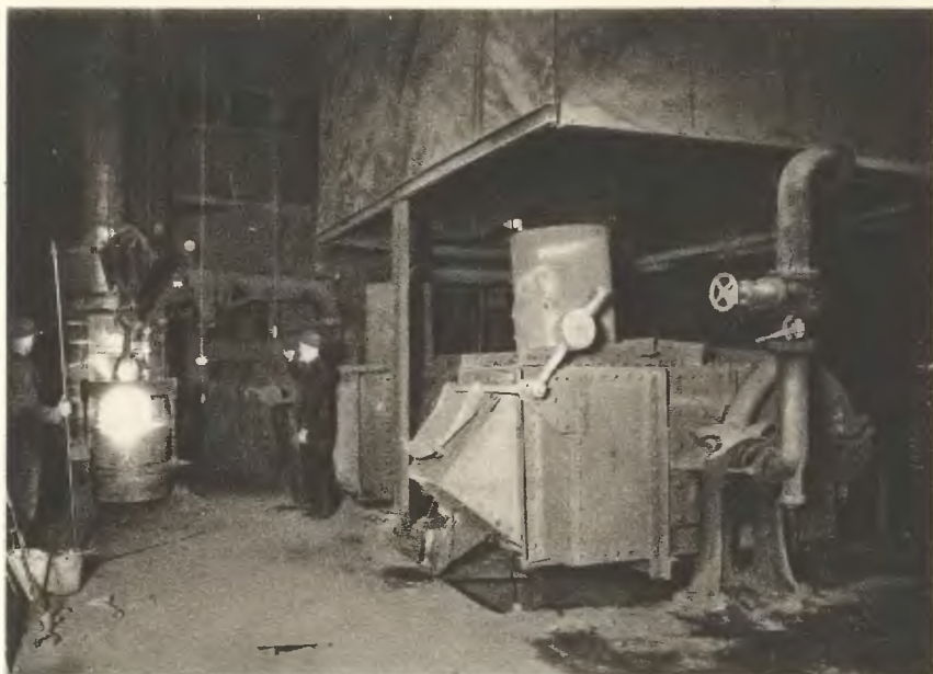
Ryc. 52. Gruszki Bessemerowskie i mały żeliwiak w odlewni Zakładów Budowy Maszyn »Huta Zgoda«.
