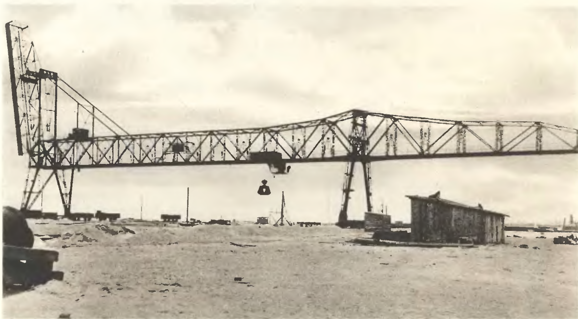
Ryc. 29. Pierwszy most przeładunkowy na molu węglowym w Gdyni wykonany w r. 1926 przez Zakłady Budowy Maszyn »Huta Zgoda«.
