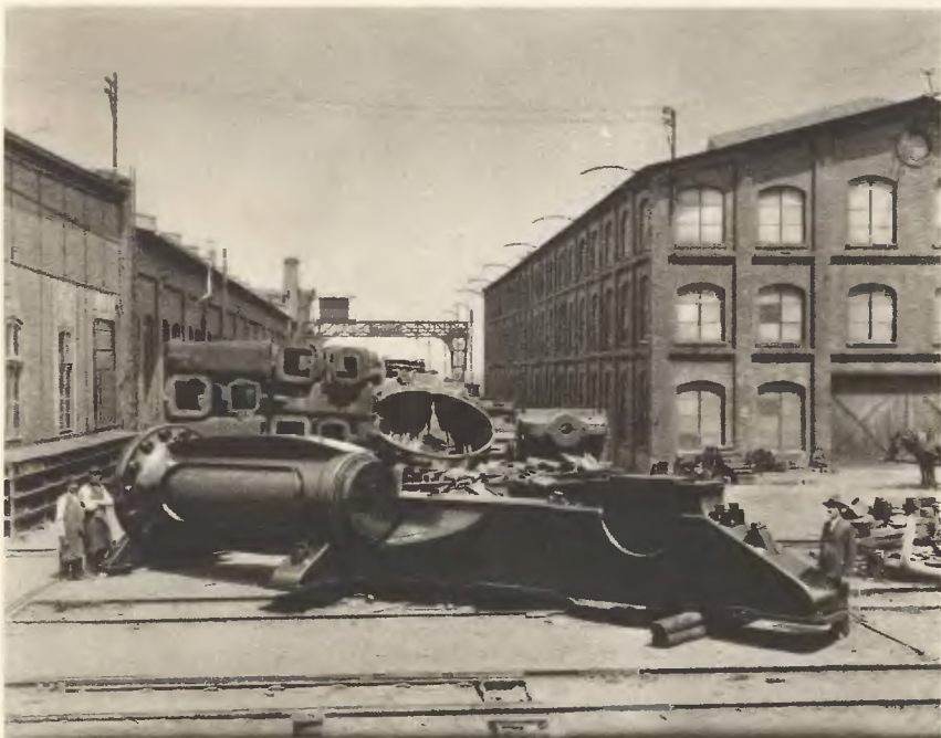
Ryc. 39. Model ramy kopalnianej maszyny parowej w czasie transportu ze stolarni modelowej do odlewni.
