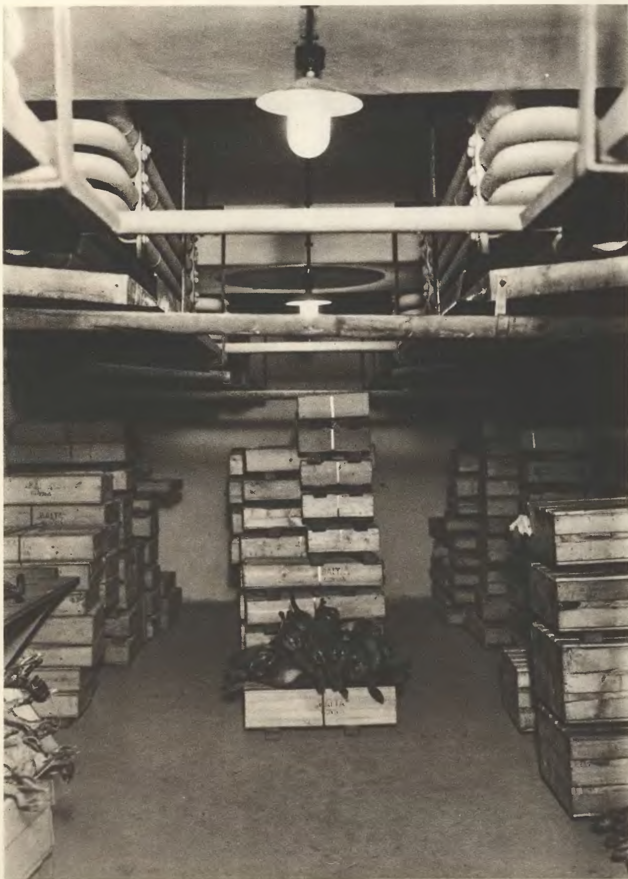
Wnętrze chłodni warzyw w Hali Targowej w Gdyni. Pod stropem widoczne wężownice solankowe, wykonane przez Zakłady Budowy Maszyn »Huta Zgoda«.
