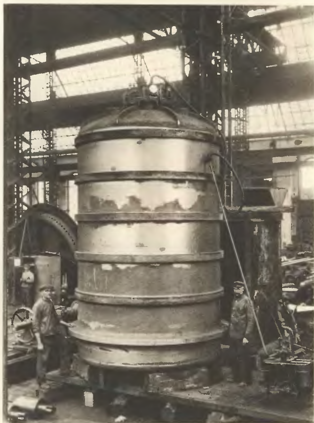
Ryc. 46. Część wyparnika dla fabryki chemicznej w czasie próby ciśnienia w warsztacie. Zwraca uwagę odlew z pełnym dnem i bardzo małym otworem wlotowym.
