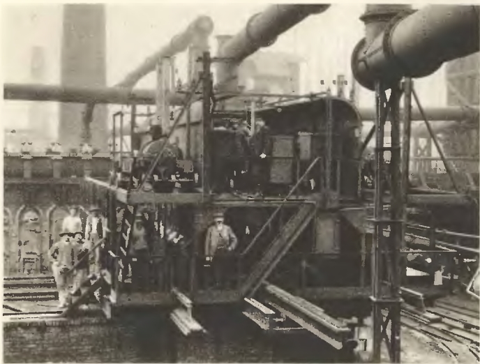
Ryc. 17. Maszyna do wypychania koksu w hucie »Piłsudski« wykonana przez Zakłady Budowy Maszyn »Huta Zgoda« w r. 1905.
