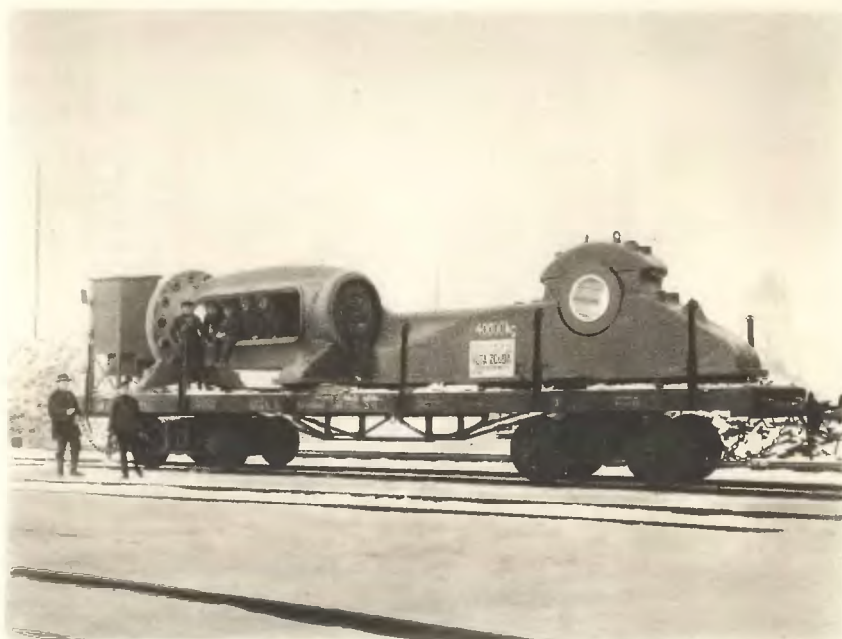
Ryc. 45. Rama kopalnianej maszyny parowej (z ryc. 39) po całkowitej obróbce załadowana na wagon.
