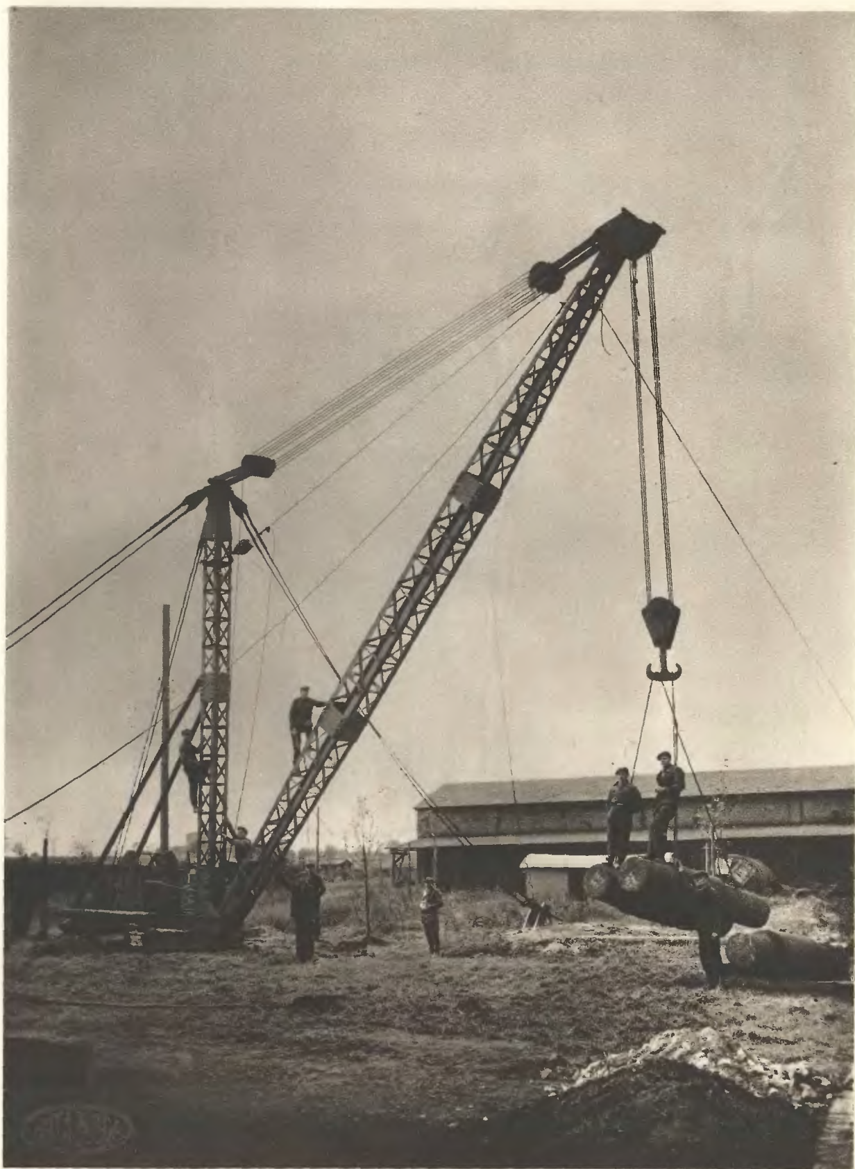
Żuraw obrotowy syst. »Derrick« o nośności 20 ton i wysięgu 4 do 12 m dla celów montażowych, wykonany przez Zakłady Budowy Maszyn »Huta Zgoda«.
