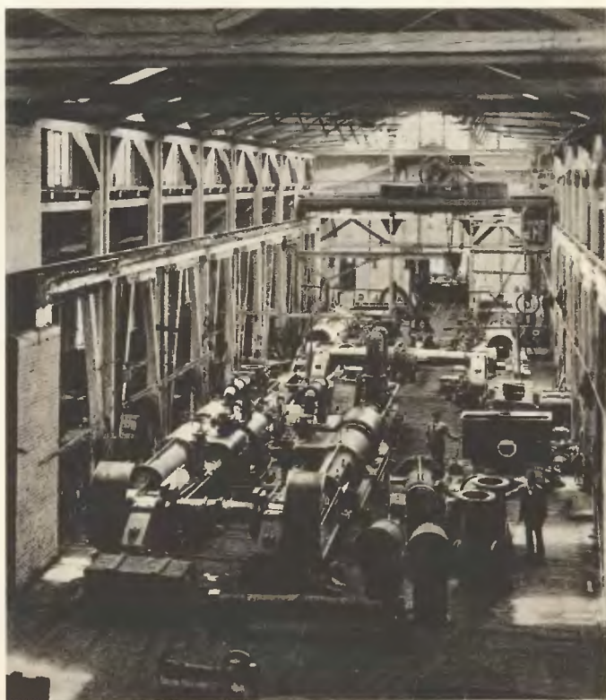
Ryc. 16. Montaż pompy kopalnianej napędzanej bliźniaczą maszyną parową tandem w warsztacie Zakł. Bud. Masz. »Huta Zgoda«.
