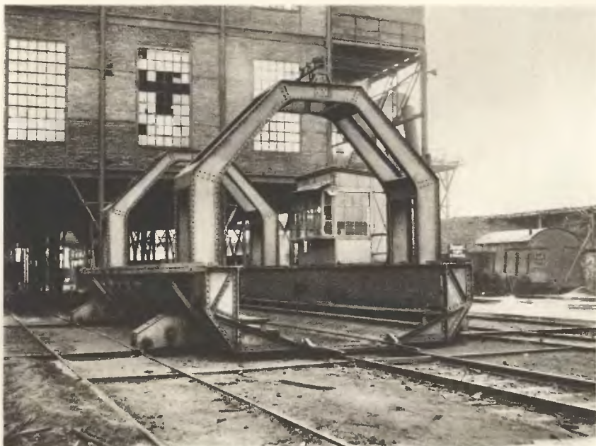
Ryc. 30. Bramiasta przesuwница wagonowa o nośności 100 ton na kopalni »Dębieńsko« wykonana przez Zakłady Budowy Maszyn »Huta Zgoda« w r. 1938.
