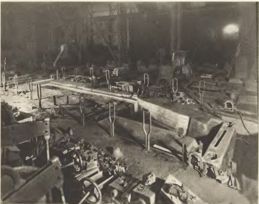
Ryc. 40. Otwarta forma dla odlewu ramy maszyny parowej z ryciny 39.
