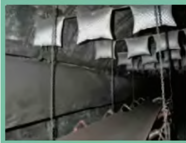
Montaż zawiesi trasy kolejki podwieszanej
