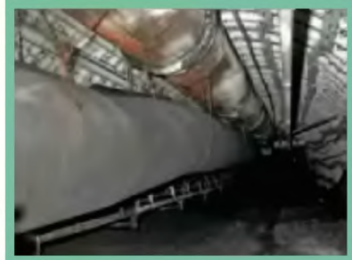
Montaż zawiesi trasy kolejki podwieszanej
