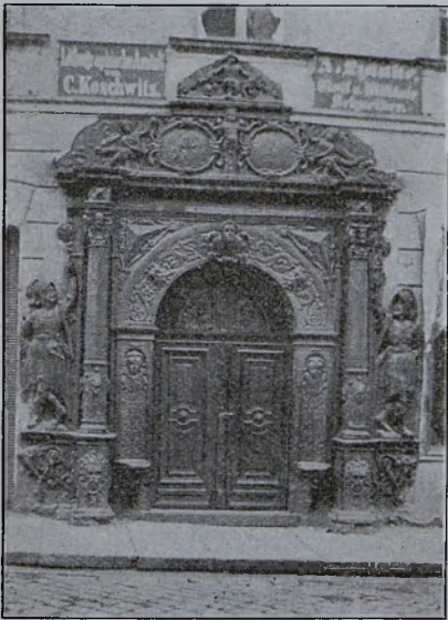
Portal in der Biegnitzer Straße in Zauer.
