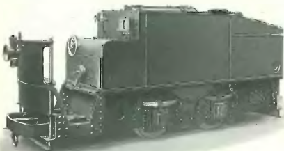
Fig. 403. Benzin-Grubenlokomotive der Gasmotorenfabrik Deutz.
