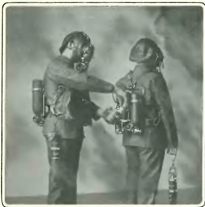
Fig. 561. Auswechseln einer Patrone in unatembaren Gasen beim neuen Drägerschen Helm-Atmungsgerät.
