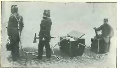
Fig. 551. Königsche Druckschlauch-Atmungsgeräte für Nasenatmung, nebst Luftschlauch und Blasebalg.
