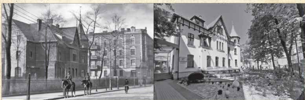
Siedziba Funduszu Górnośląskiego kiedyś i dziś (Katowice ul. Sokolska 8)
