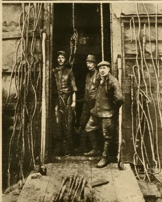
Wejście do szyby. Po prawej i lewej stronie dłuta wiernicze przeszło metrowej długości, ważące od 200 do 300 kg.
