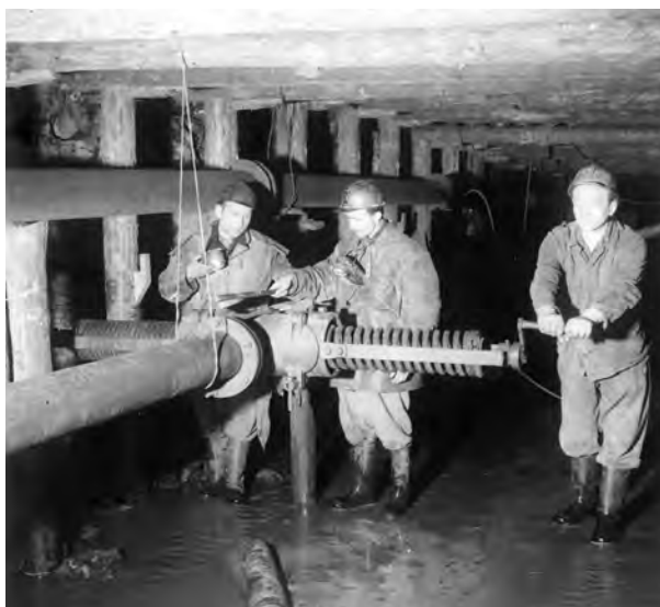
Gęstościomierz suwakowy zastosowany w instalacji pomiarowej „Koszelew” – wraz z obsługą (1961)
