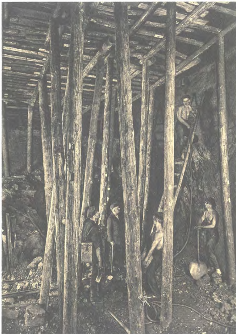
Takie wyrobisko jak kościół – „las drewnianej obudowy i „górnicy na węglu”! Tak wyglądały filary również w kopalni „Barbara-Wyzwolenie” („Czarne diamenty” M. Steckel, Katowice 1929)
