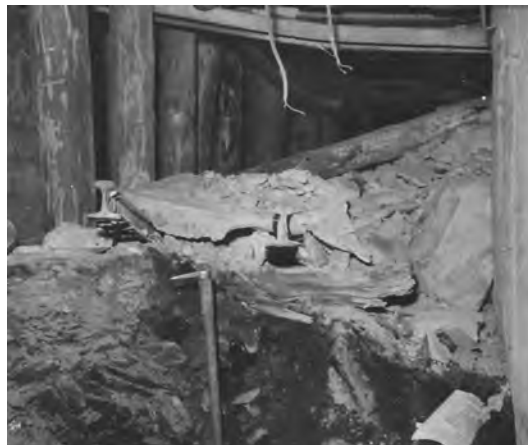
Niekiedy – aby chodnik dwustronnie otoczony zrobami doprowadzić do stanu używalności – trzeba było przybierać metrową warstwę wypiętrzonego spągu
