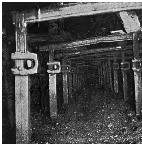
Tak wyglądał przodek ścianowy w ówczesnej stalowej obudowie. Po lewej stronie ocios węglowy; po prawej niewidoczny przenośnik taśmowy i za nim – zroby zawalowe
