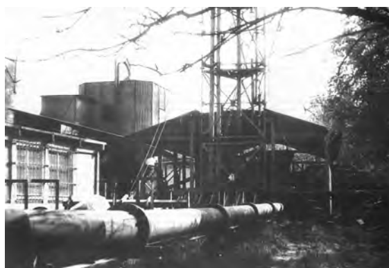
Instalacja ZIP.1M. Na pierwszym planie – rurociąg pomiarowy
