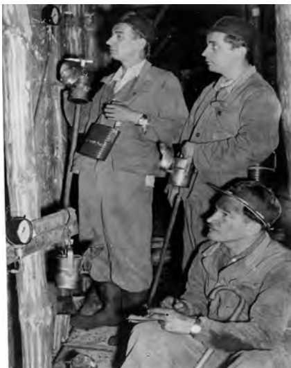
Dołowe pomiary naporu podsadzki hydraulicznej na tamę czołową w kopalni „Sosnowiec”. Wskazania manometrów obserwują inżynierowie z kopalni. Od lewej: Światowski i Sendor (później dyrektor kopalni) – oraz ja (1960 r.)
