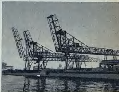
Mosty przeładunkowe w Gdyni
