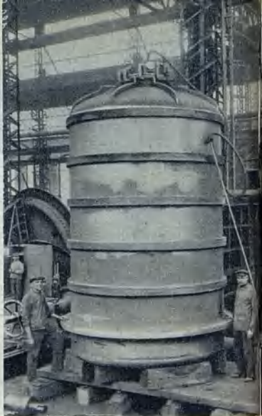
Warnik z żeliwa ługo- odpornego dla fabryki chemicznej
