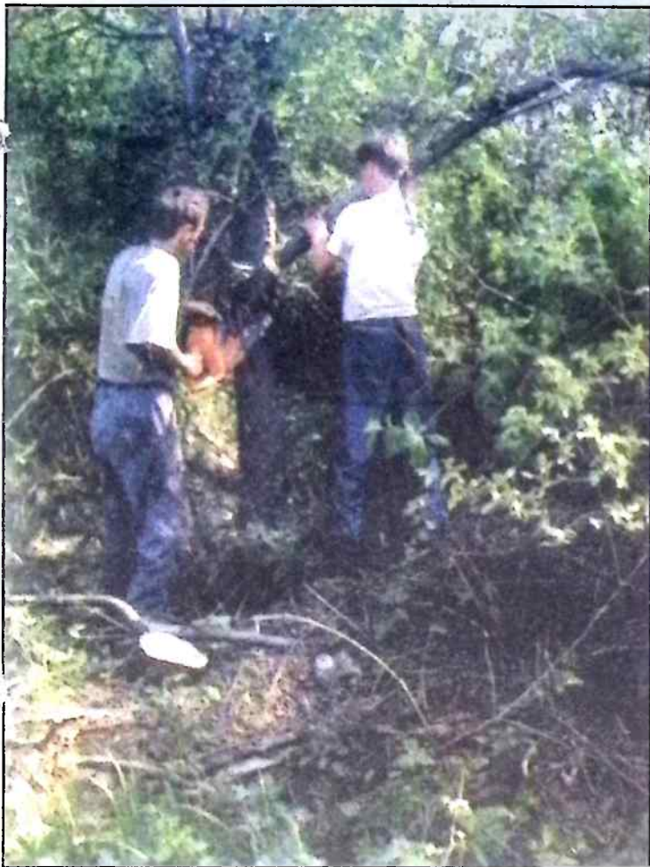
W poniedziałek drwale rozpoczęli wycinkę drzew pod przyszłą autostradę
