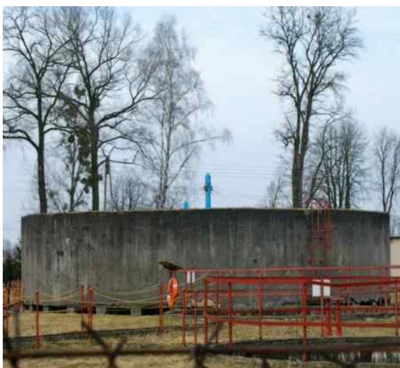
Oczyszczalnia - stan obecny
