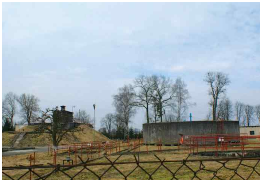
Oczyszczalnia - stan obecny
