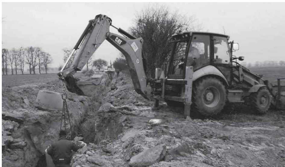
Budowa kanalizacji w Brzezinkach.
