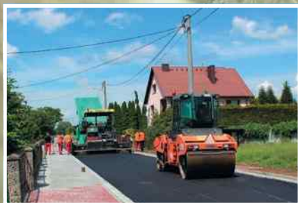
Budowa drogi na ulicy Polnej w Wołczynie
