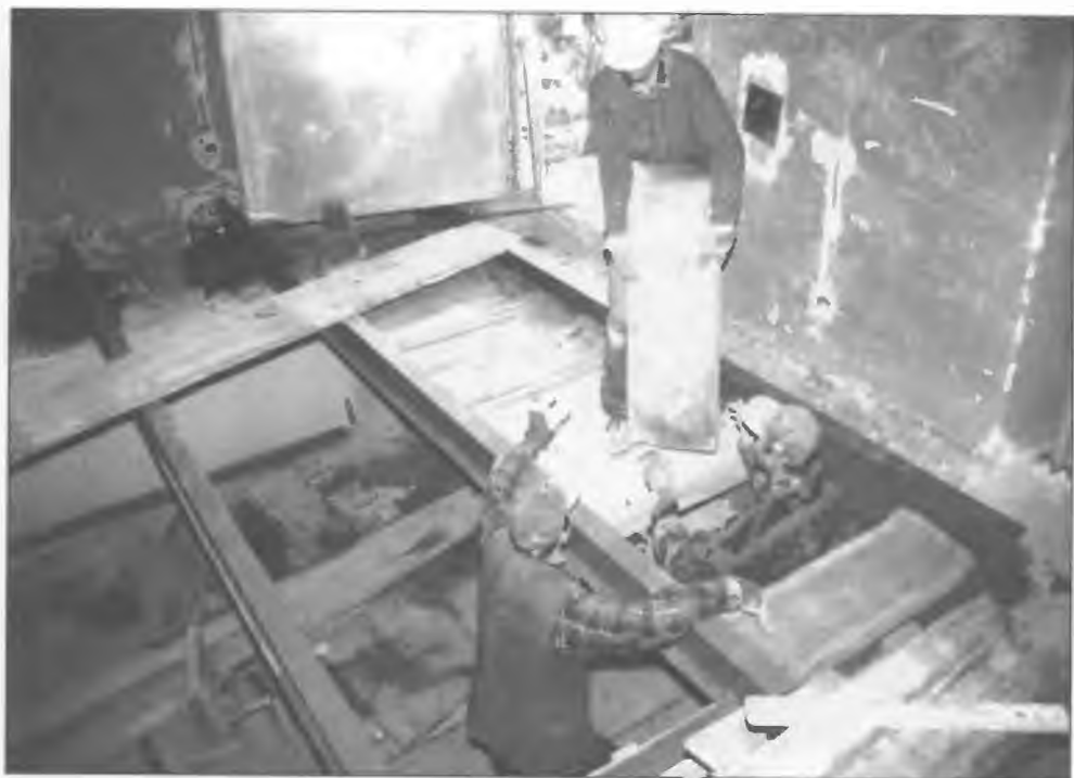
Wymiana stropów na II piętrze pałacu.
