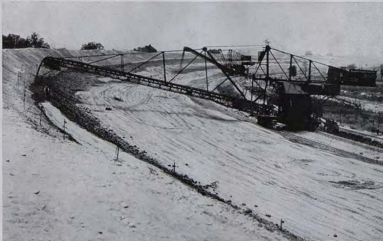
Abb. 5. Das Absetzgerät baut die Tondichtung mit nachfolgender Deckschicht auf dem fertigen Stützkörper ein.
