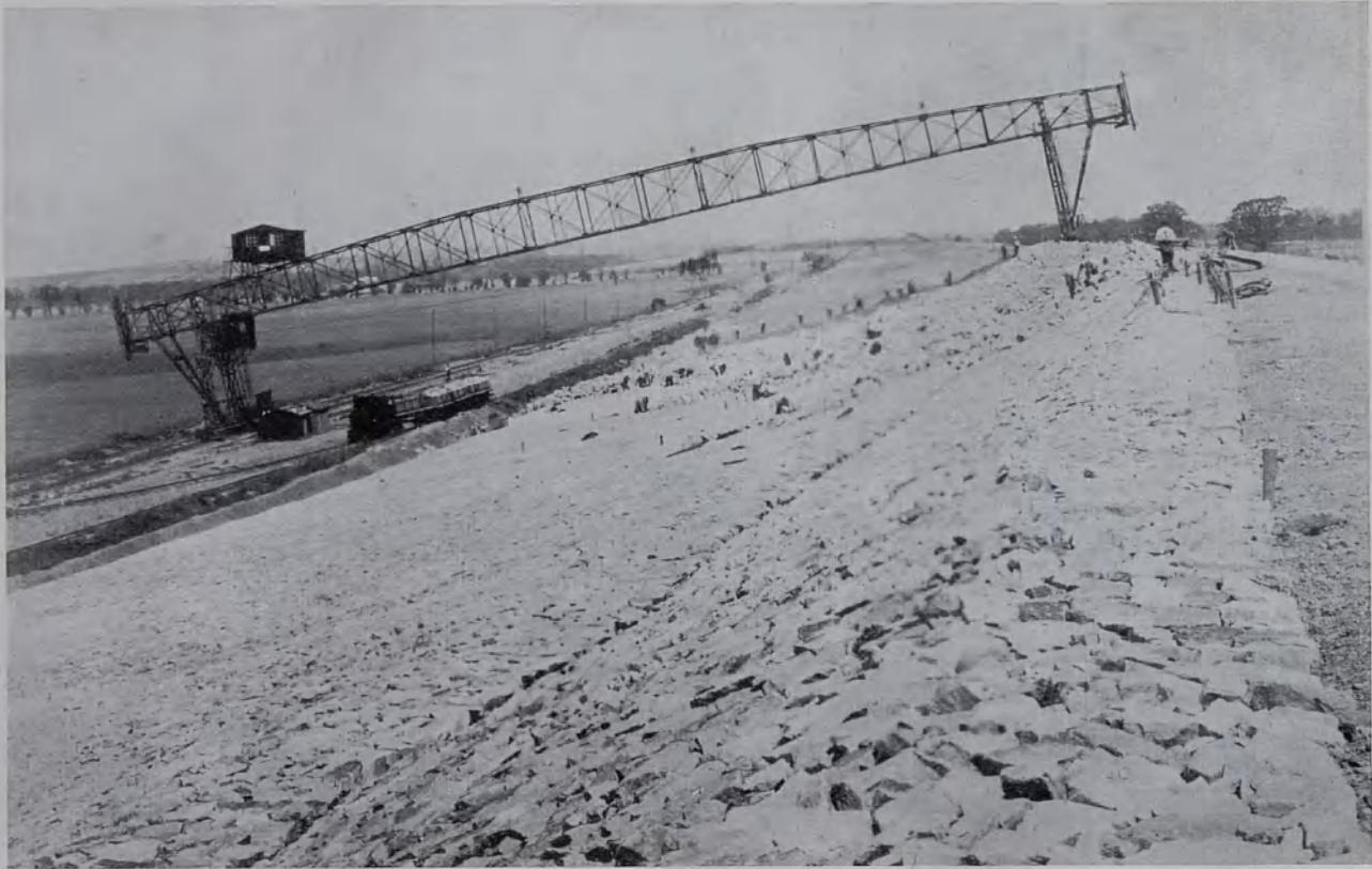
Abb. 6. Die aus Splitt, Schotter und Bruchsteinen bestehende Steindecke mit filterartigem Aufbau wird mittels Kabelkranbrücke aufgebracht.
