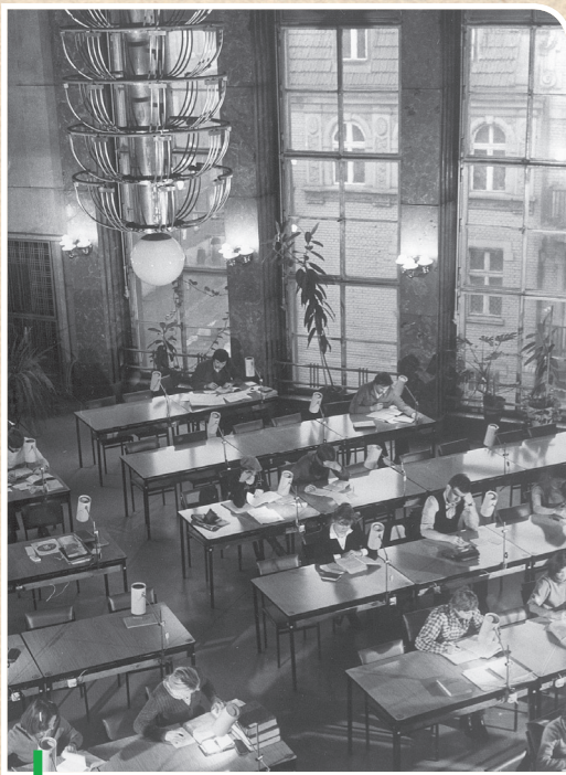
Czytelnia Główna w budynku Biblioteki Śląskiej przy ulicy Francuskiej (lata 70. XX wieku)
