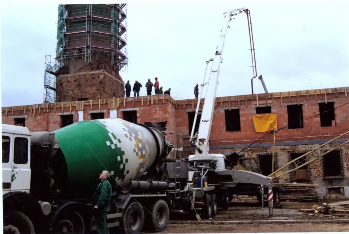
KONIEC LISTOPADA 2006 - WYLEWANIE STROPU I PIĘTRA RATUSZA.
