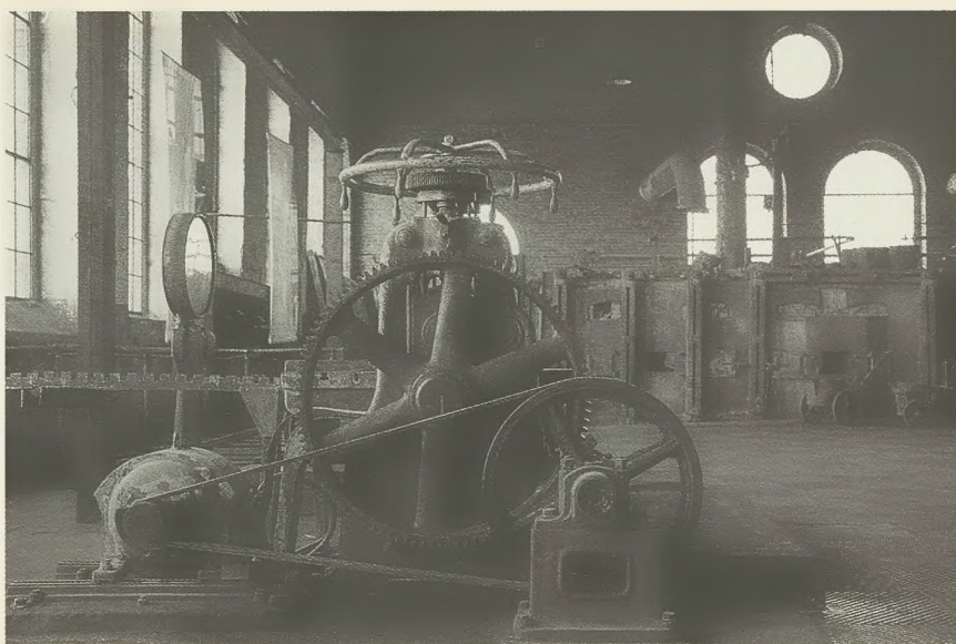
Nożyca krążkowa. Urządzenie służyło do obcinania nierównych krawędzi odwalcowanych taśm cynkowych. Do napędu wykorzystano silnik elektryczny.
