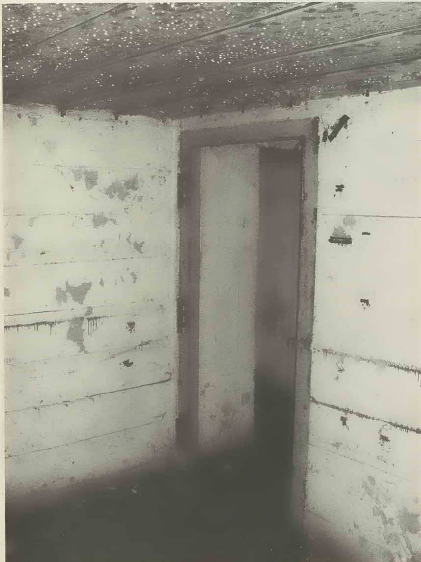
Schron nr 13 – wejście do obiektu
