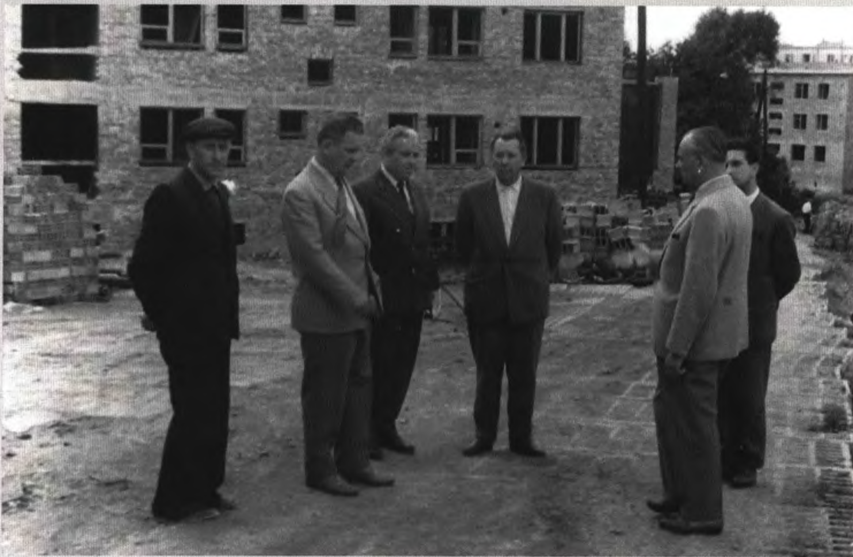
Minister górnictwa Jan Mitręga (drugi z lewej) i dyrektor KWK Jastrzębie-Moszczenica w budowie Włodzimierz Ostaszewski (trzeci z lewej) na placu budowy osiedla w Zdroju / Fot. autor nieznany (IX 1961) / Arch. rodzina Ostaszewskich
