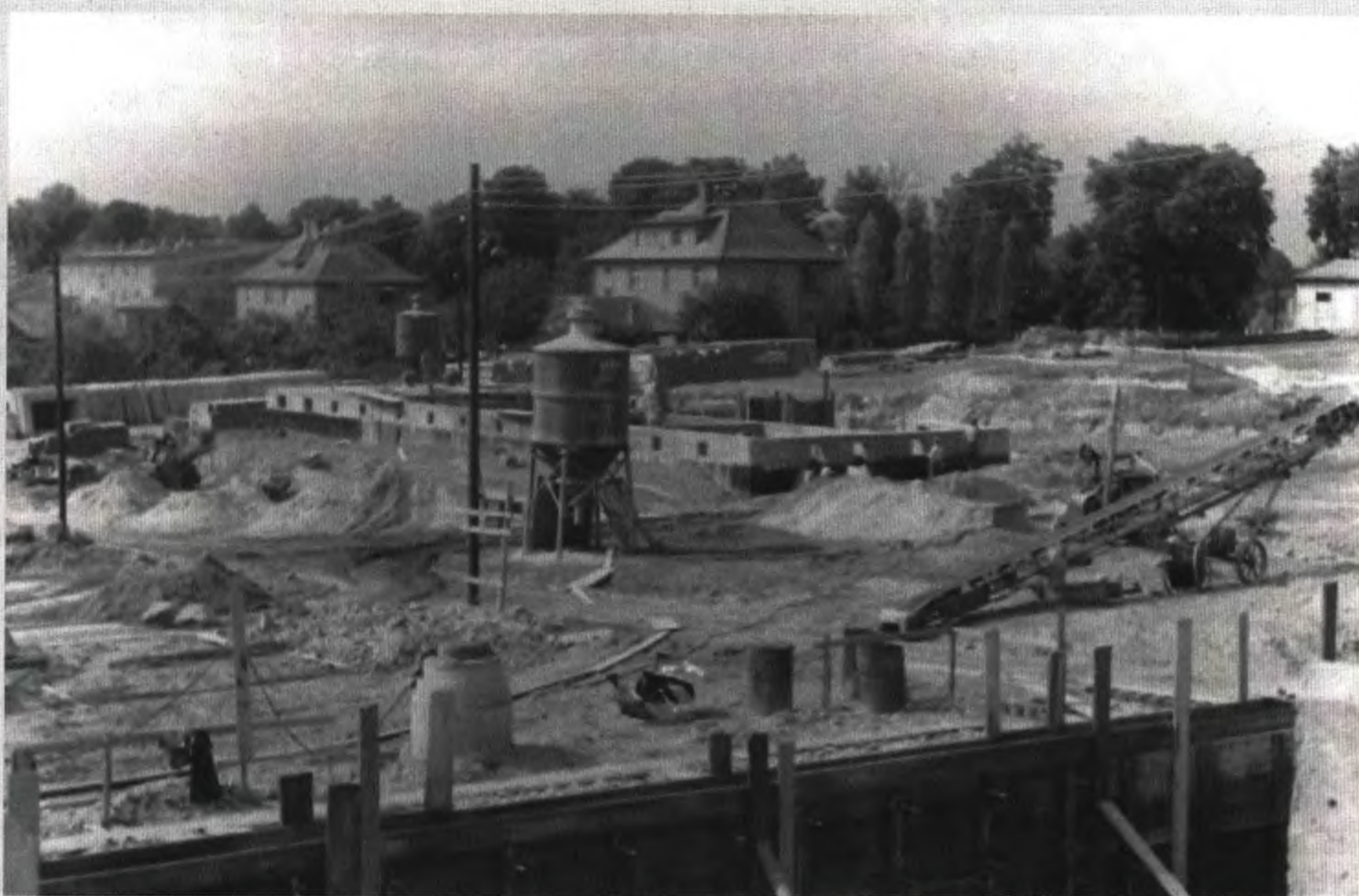
Budowa bloków mieszkalnych przy ulicy Słonecznej, w tle budynki przy ulicy 1 Maja / Fot. autor nieznany (IX 1961) / Arch. rodzina Ostaszewskich
