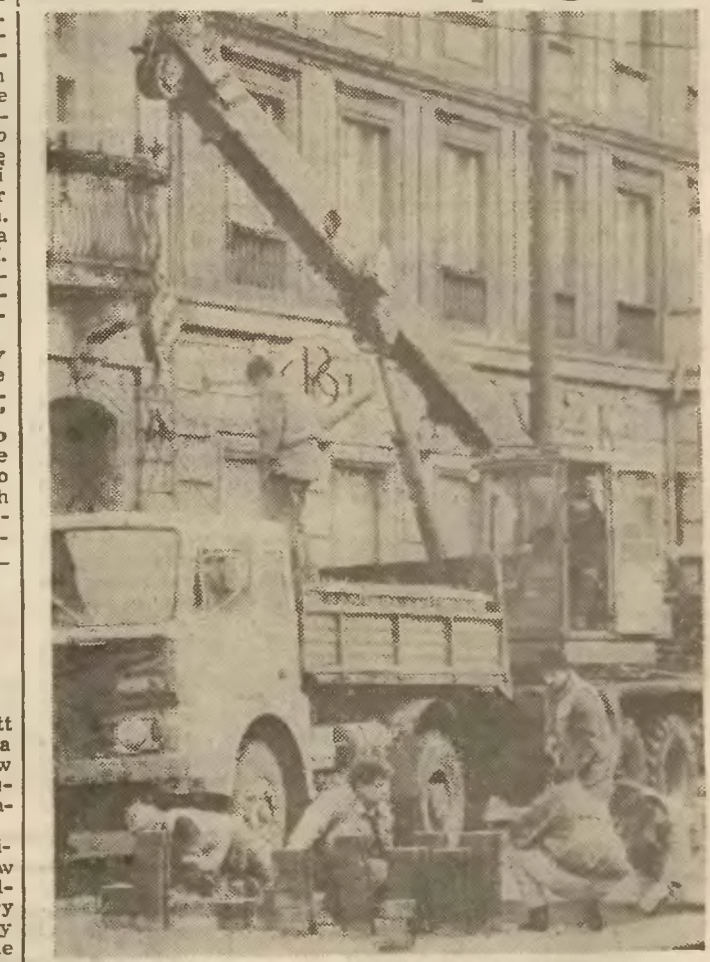
O takiej wiosennej pogodzie w styczniu niektórzy marzyli! Ekipy fachowców mogą bez przeszkód dokonać remontu ulicy Warszawskiej w Katowicach.
