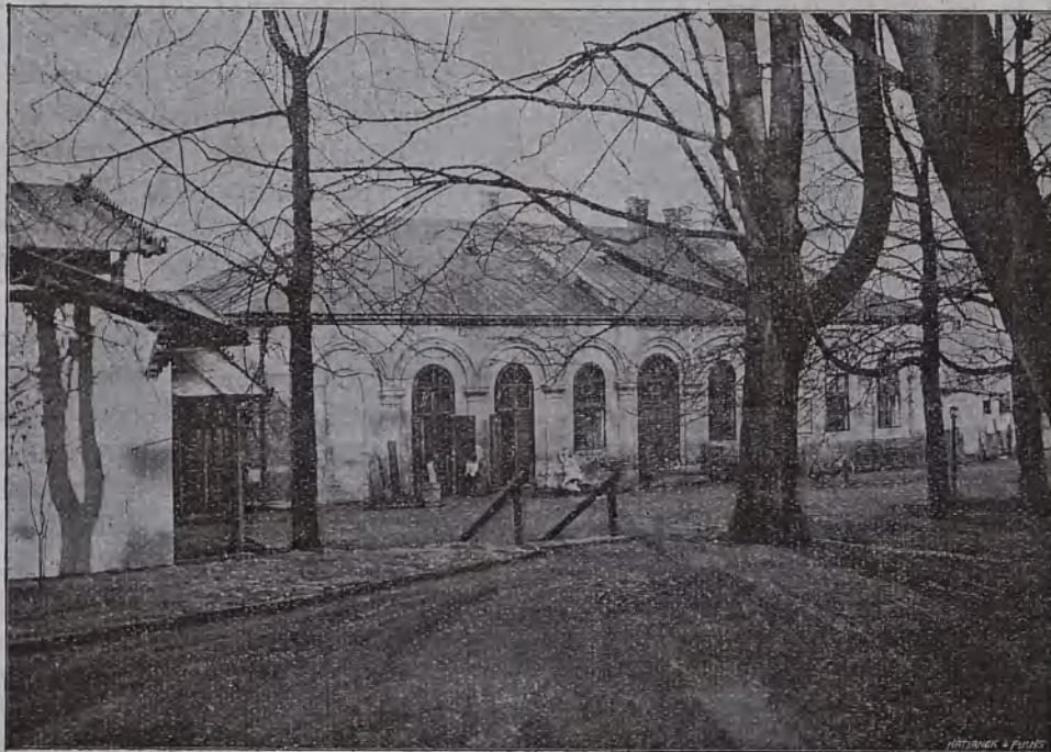
Die alte Vereinsturnhalle auf der Schießstätte.
