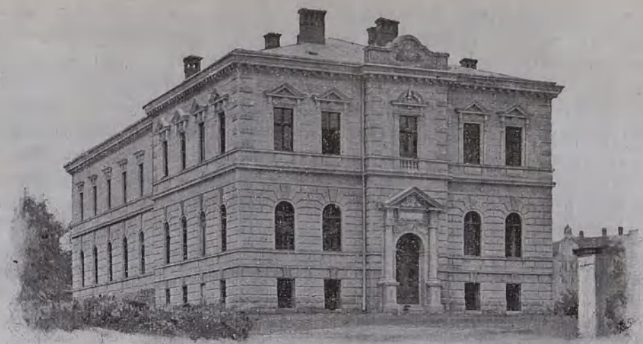
Äußere Ansicht der neuen Vereinsturnhalle in der Schießhausstraße.
