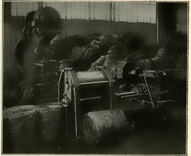
Abbildung 4. Schrottwickelmaschine der Deutschen Maschinenfabrik.
