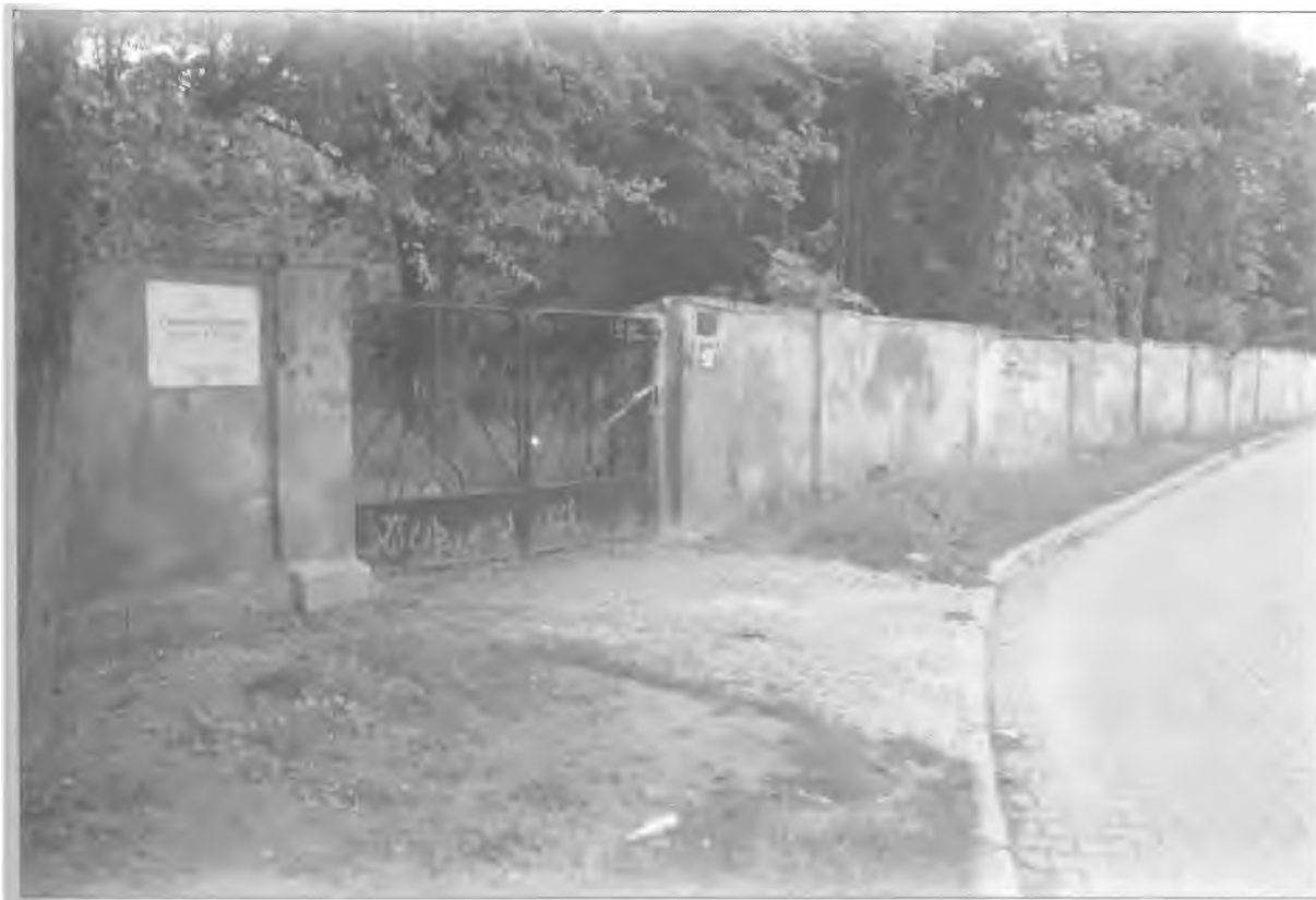
Mur cmentarny i brama wejściowa – strona południowa (2003)
