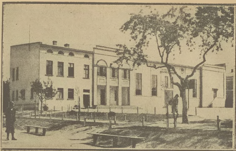
Sala gimnasyryczna i bursa przy Gimnazjum Diecezji Częstochowskiej w Wieluniu.
