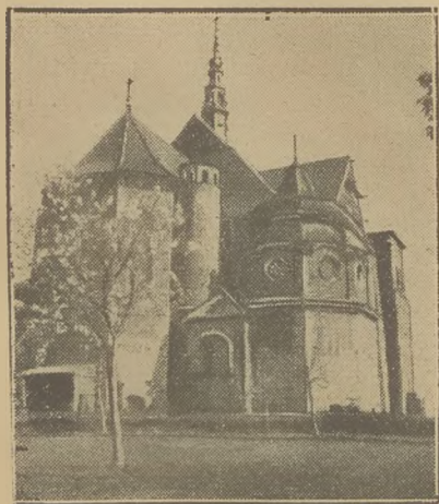
Widok ze strony południowej.
