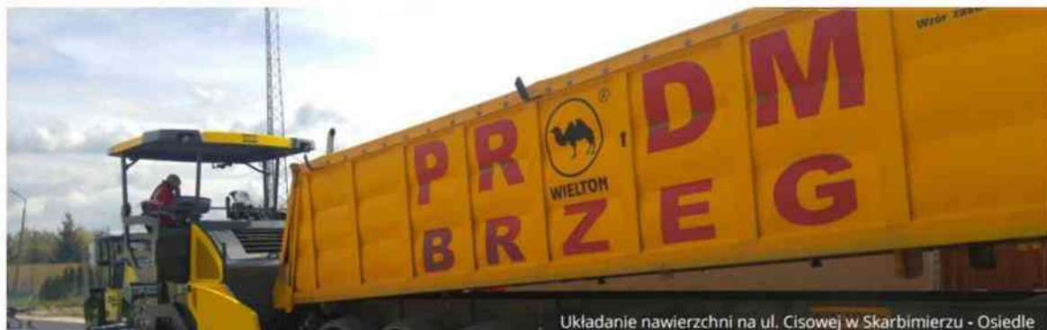
Układanie nawierzchni na ul. Ciszowej w Skarbmierzu - Osiedle
